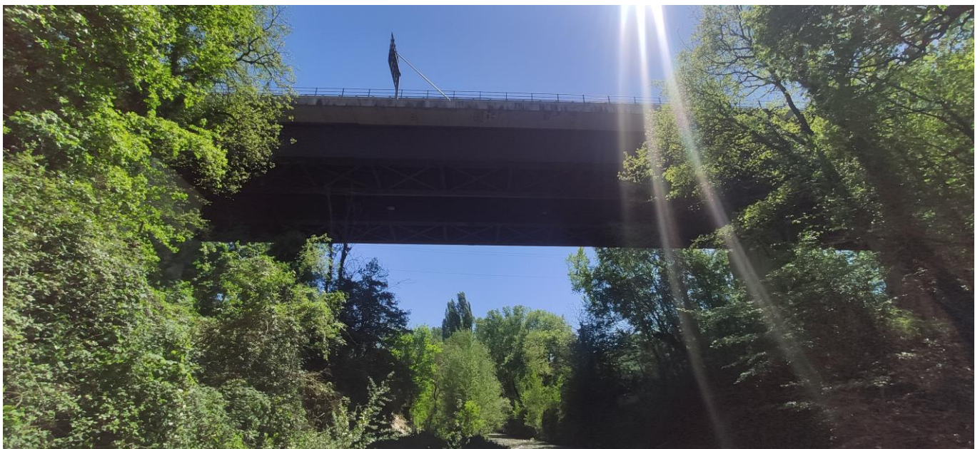
Fig. 4 – Ponte stradale esistente della SS76 sul Torrente Giano, in corrispondenza del passaggio a livello alla progressiva Km 229+436.
