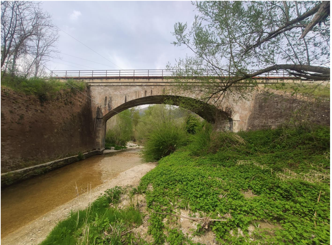
Fig. 5 – Ponte ferroviario esistente sul Fiume Esino, nei pressi di Albacina.
