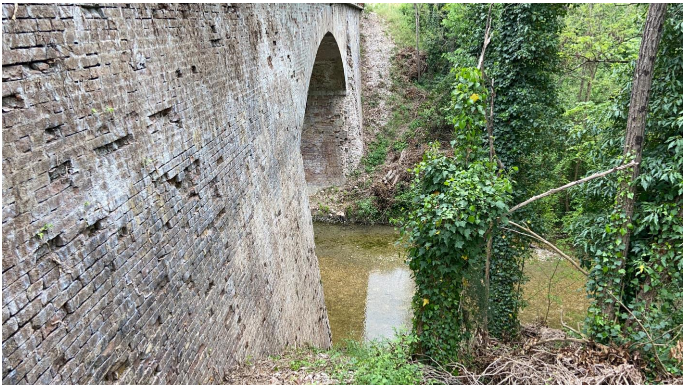
Fig. 6 – Ponte ferroviario esistente sul Torrente Giano, nei pressi di Albacina.
