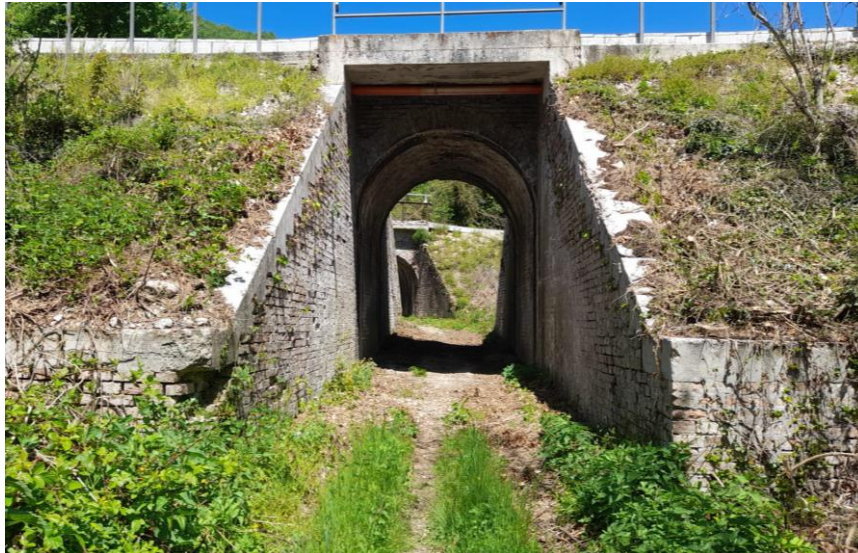
Fig. 36 – S11 – Vista Prospetto sud
