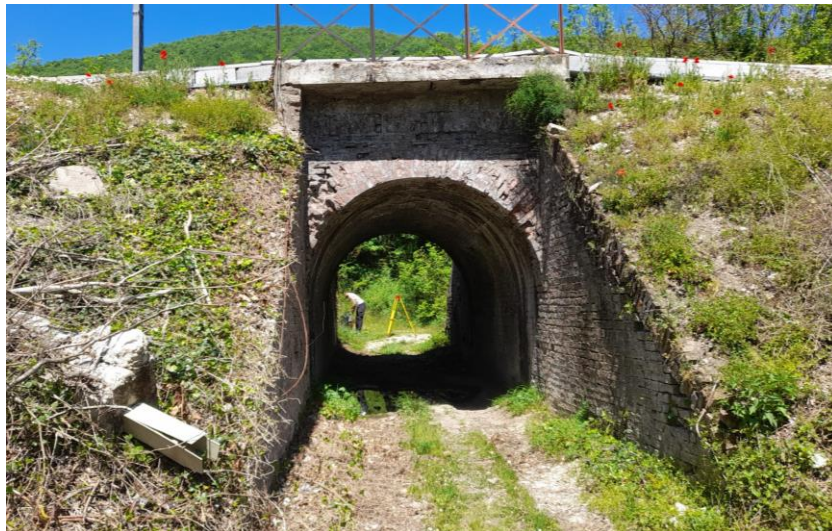
Fig. 34 – S10 – Vista Prospetto sud
