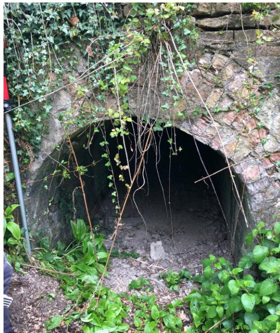
Fig. 25 – S7 – Vista arco in mattoni Prospetto nord
