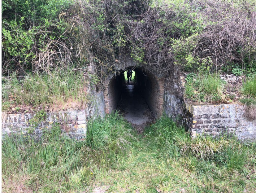
Fig. 17 – S5 – Vista Prospetto sud
