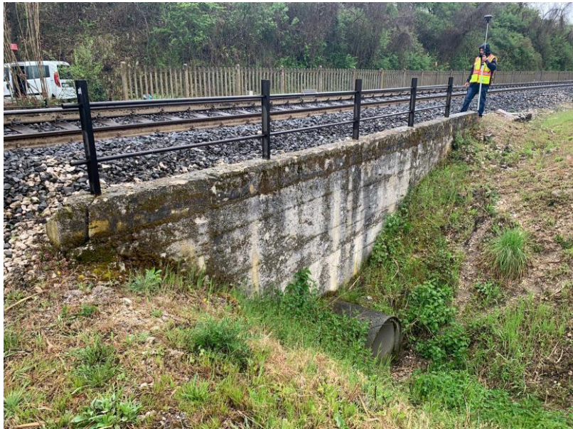
Fig. 24 – S7 – Vista tubo in cls Prospetto sud
