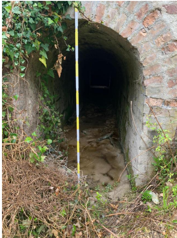
Fig. 28 – S8 – Vista Prospetto sud
