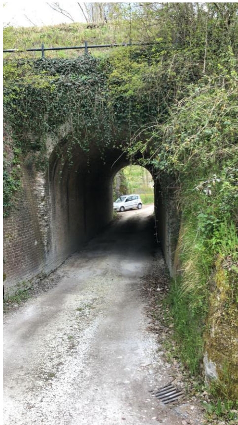
Fig. 12 – S4 – Vista sottopasso Prospetto sud
