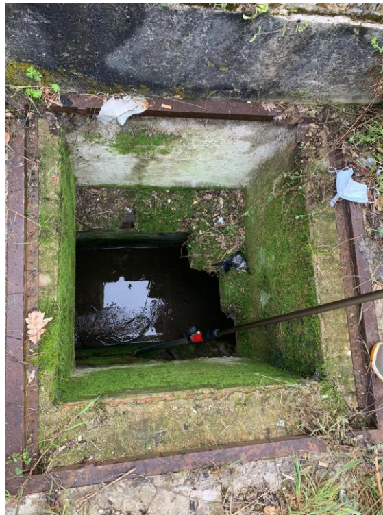
Fig. 10 – S3 – Vista opera da demolire
