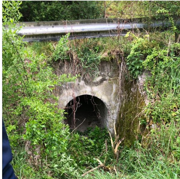
Fig. 20 – S6 – Vista Prospetto sud
