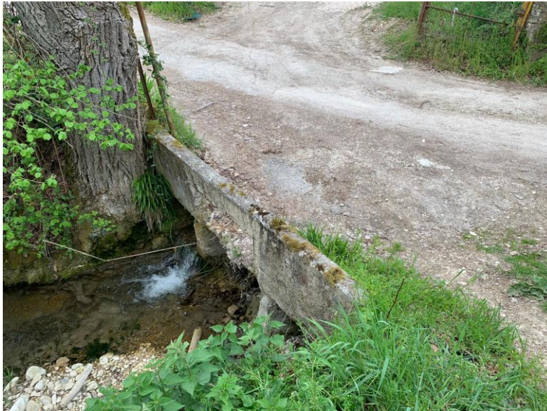
Fig. 13 – S4 – Scolo idraulico sottopassante la strada carrabile
