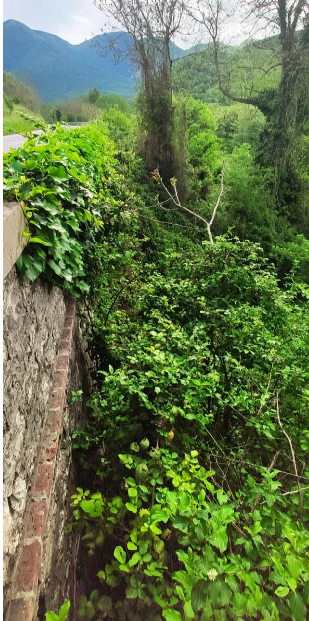
Fig. 30 – S9 – Vista sottopasso idraulico Prospetto sud
