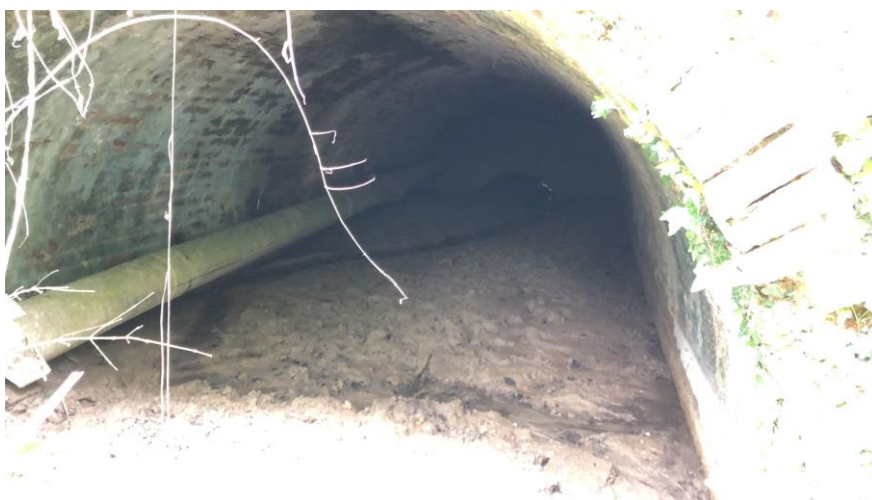
Fig. 2 – S1 – Vista Prospetto sud
