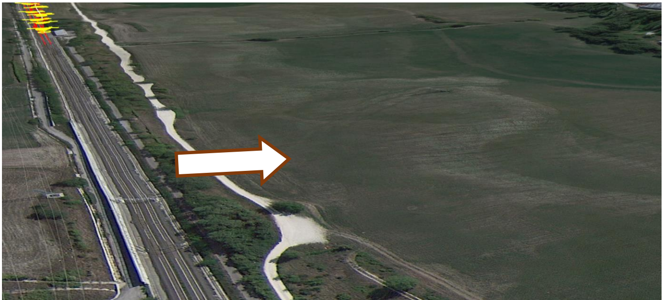
Foto dell'area di cantiere e della strada di accesso
