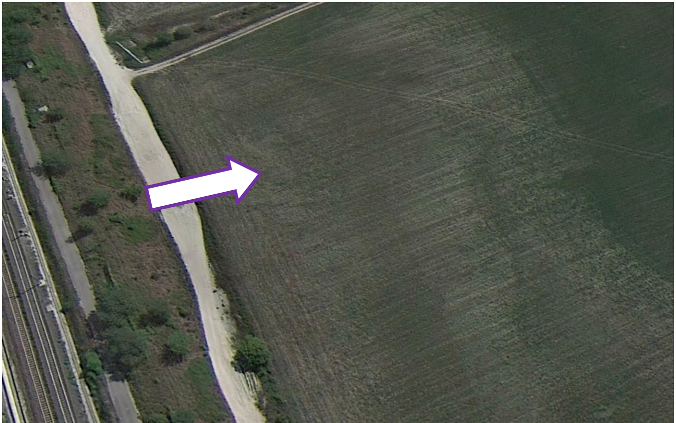
Foto dell'area di cantiere e della strada di accesso
