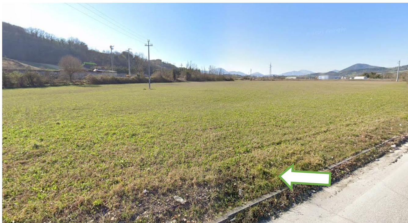
Foto dell'area di cantiere e della strada di accesso
