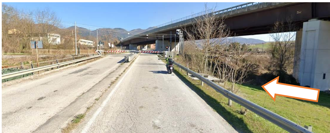
Foto dell'area di cantiere e della strada di accesso
