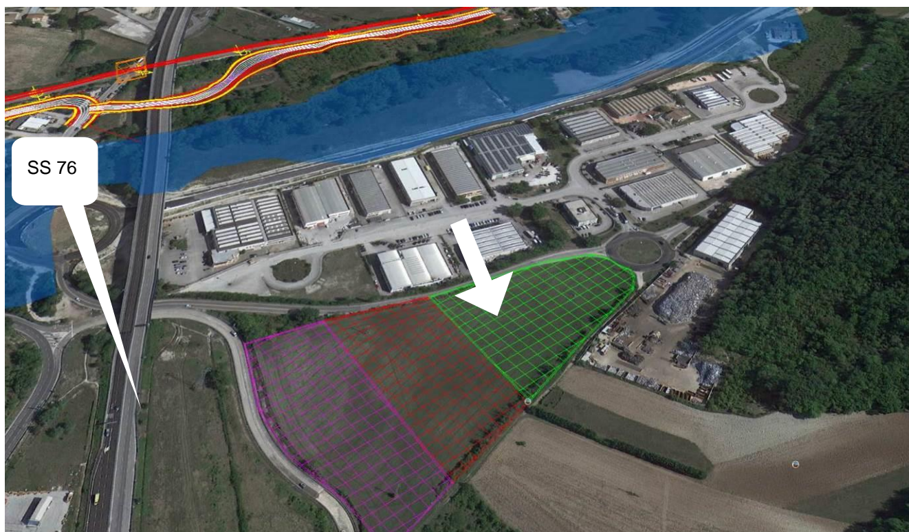
Vista aerea dell'area 4-CO.01
