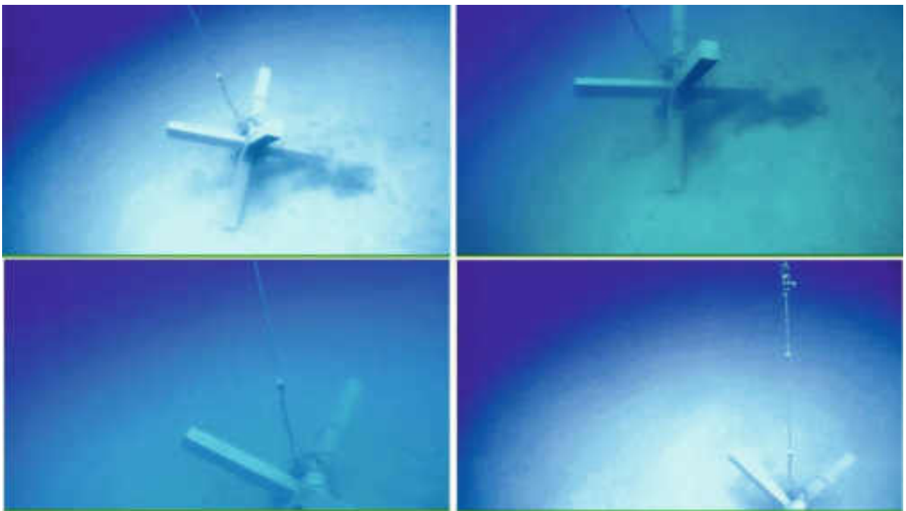
Figura 2 - Reti a strascico impigliate nei dissuasori
