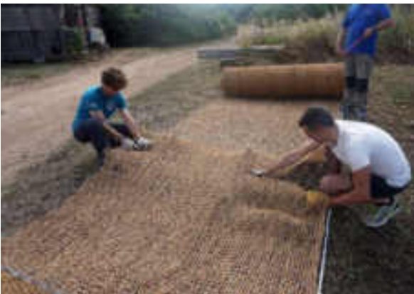
Fig. 67- Preparazione delle geostuoie prima della posa (Corsica).
