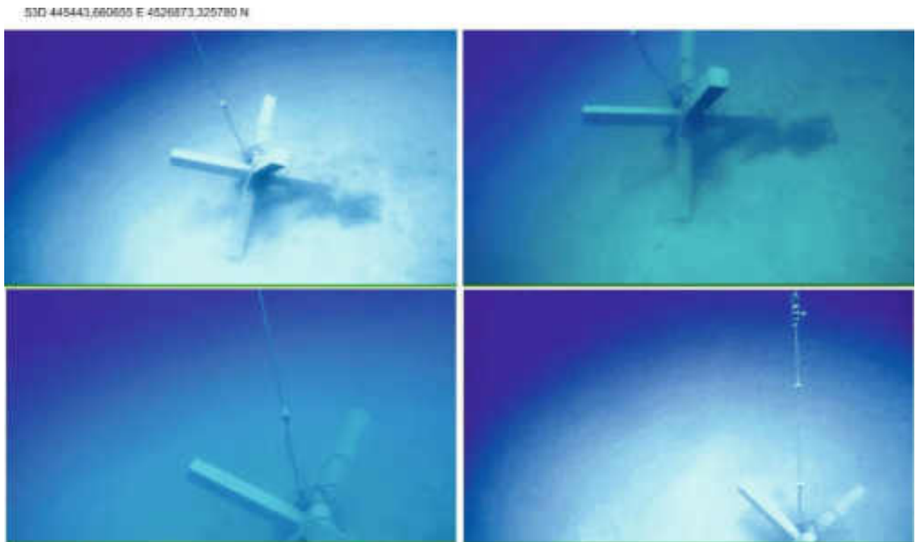
Figura 36 – Reti a strascico impigliate nei dissuasori (Fiume Santo, P. Torres, maggio 2017)
