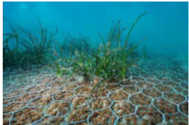
Fig. 68- Geostuoie posizionate sul fondale di Sant'Amanza
