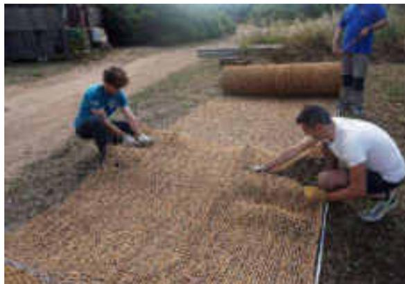
*Figura 4 - Taglio delle stuoie a Santa Manza (Corsica) nell'estate 2021*
