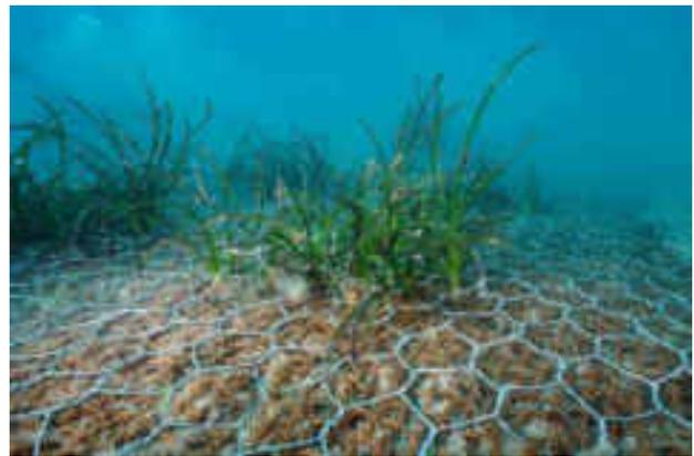
Fig. 68- Geostuoie posizionate sul fondale di Sant'Amanza
