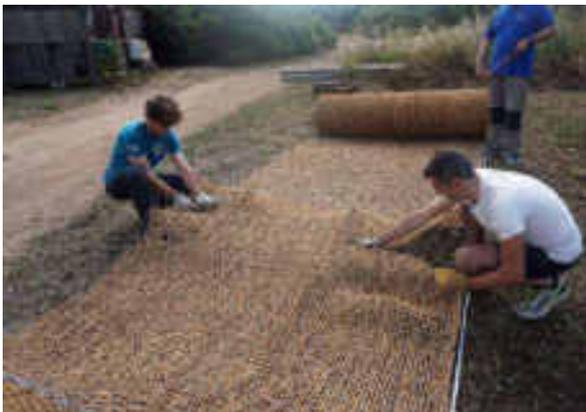
Fig. 67- Preparazione delle geostuoie prima della posa (Corsica).
