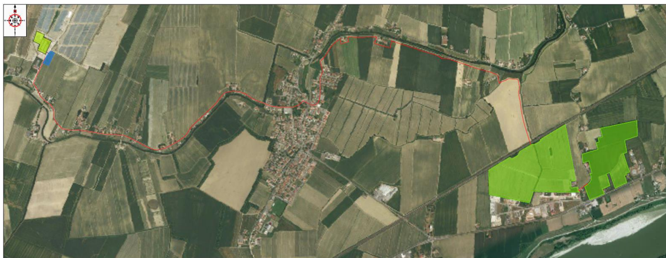
Figura 1 - Inquadramento dell'area di intervento (fonte Google Maps)
