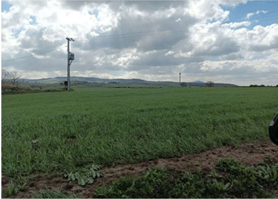
Foto 3: area piazzola di montaggio aerogeneratori WTG_13 e WTG_14
