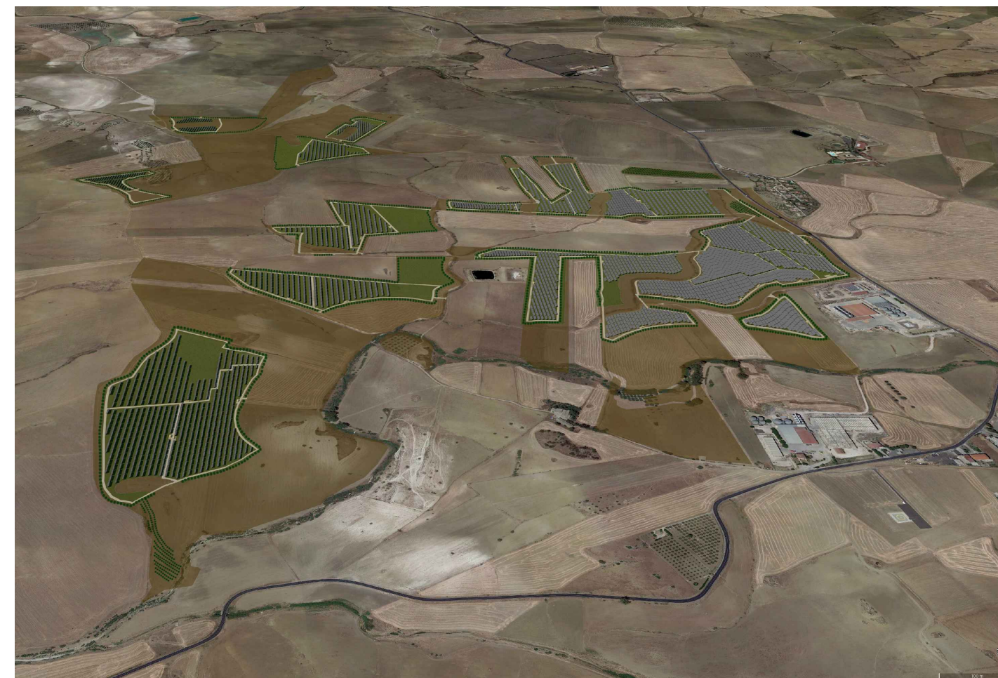
AREA SUD _VISTA OVEST
