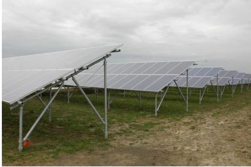
Figura 18: Esempio impianto a strutture fisse
