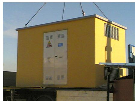
Le Cabine Elettriche prefabbricate di trasformazione omologate ENEL vengono realizzate rispettando fedelmente tutte le prescrizioni e conformità delle normative di settore (es. alla CEI 11-1 e alla CEI 0-16 e alla normativa vigente).
