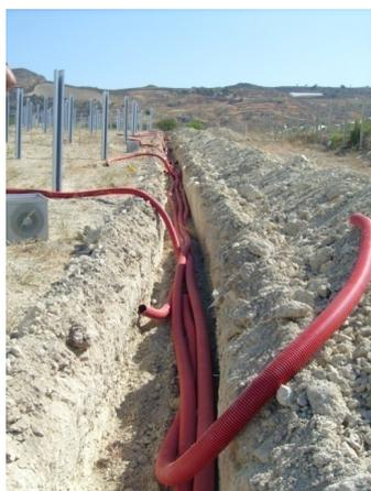
Il cavidotto avrà lo scopo di contenere i cavi che trasporteranno l'energia elettrica prodotta dalla centrale fotovoltaica al locale tecnico secondo il tracciato raffigurato in figura.
