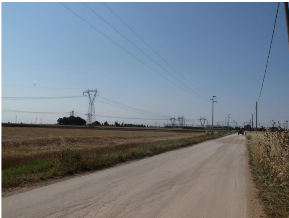
Foto 13- Stazione Elettrica di Foggia
