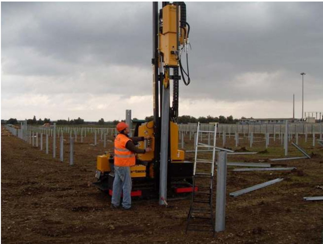
Fig. n°1 Operazione di rimozione dei pali infissi
