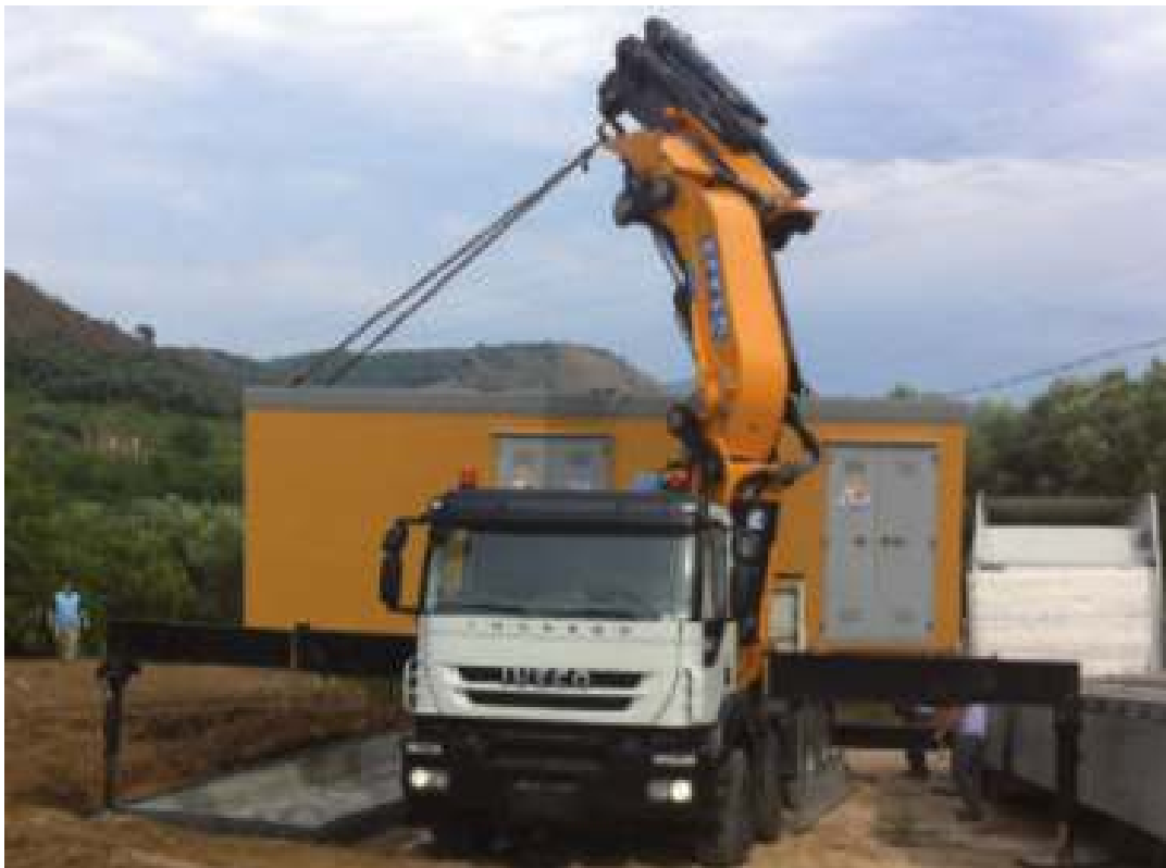
Fig. n°2 Operazione di rimozione delle cabine prefabbricate
