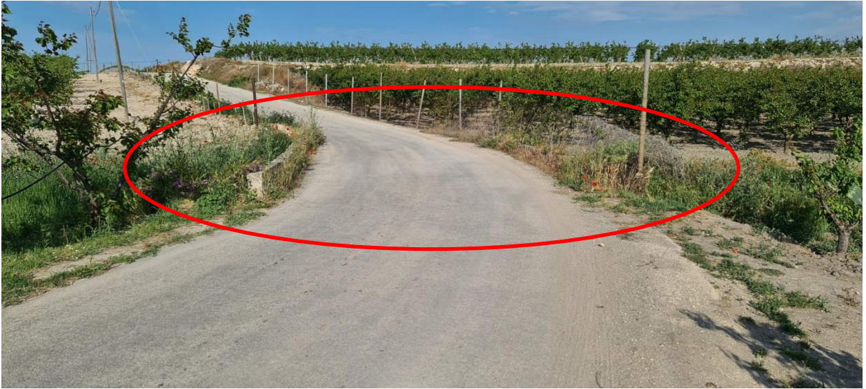
Foto n° 22 Foto dell'attraversamento della Marana Castello
