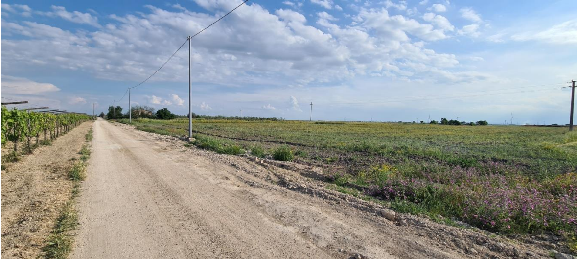
Figura 4-14: : Vista del blocco B: ante-operam
