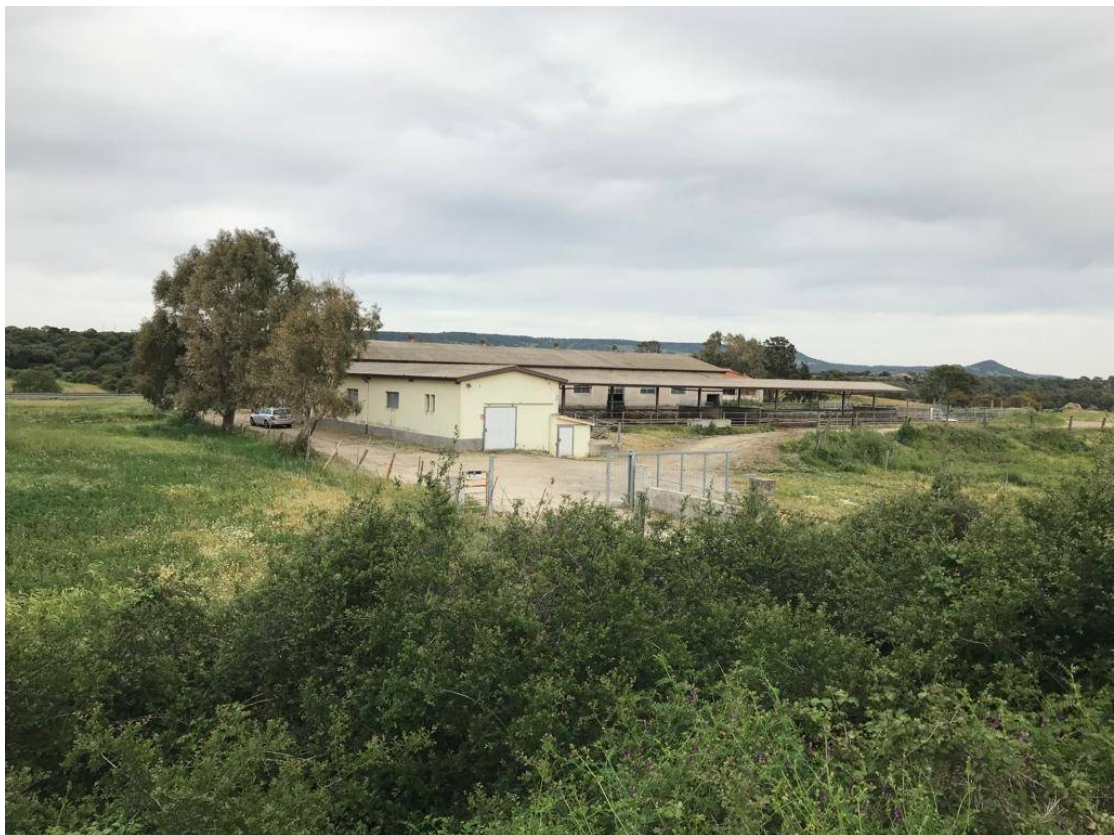
Foto n.3 e n.4. Particolari dell'area in esame, lato Nord, con la presenza del centro aziendale.
