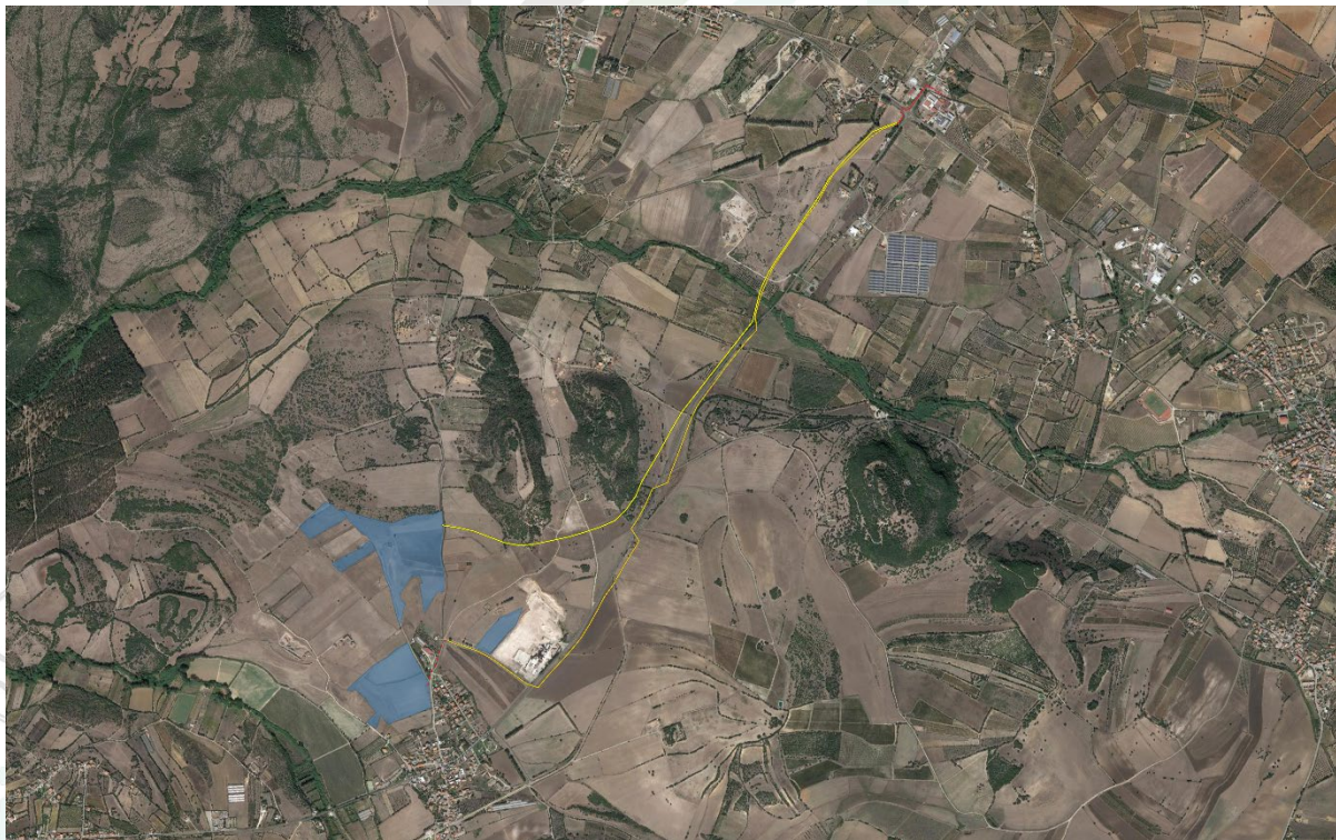
Figura 3-1: Localizzazione area di intervento: in blu la perimetrazione del sito, in giallo il tracciato aereo della connessione ed in rosso il cavidotto interrato
