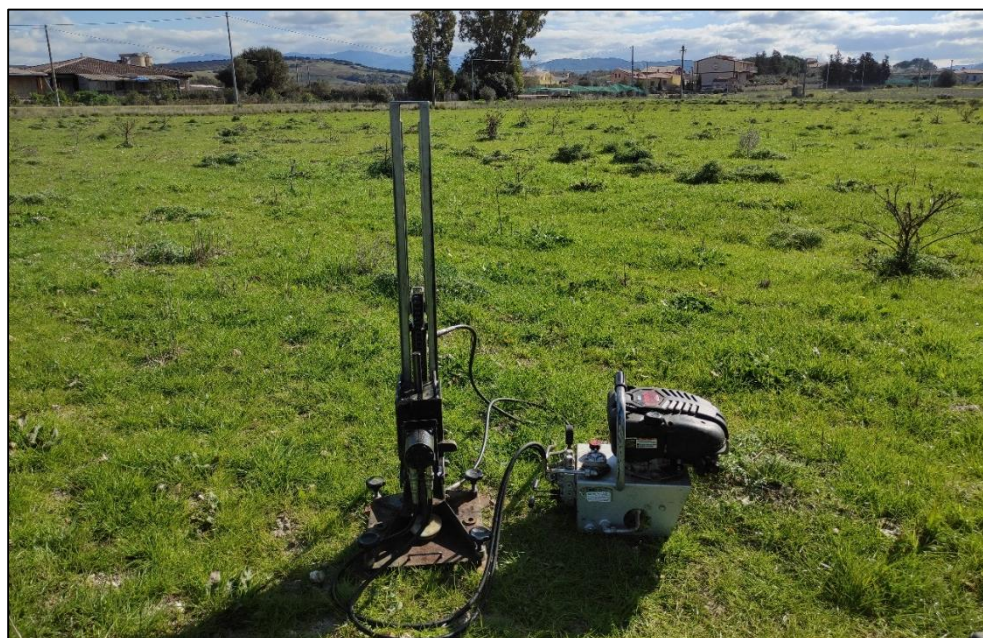
Figura 27 – Penetrometro mod. DM 30 – Deep Drill durante l'esecuzione della prova penetrometrica DIN 4.
