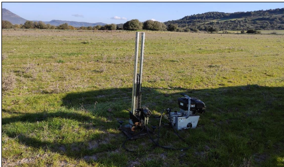
Figura 26 - Penetrometro mod. DM 30 – Deep Drill durante l'esecuzione della prova DIN 2.
