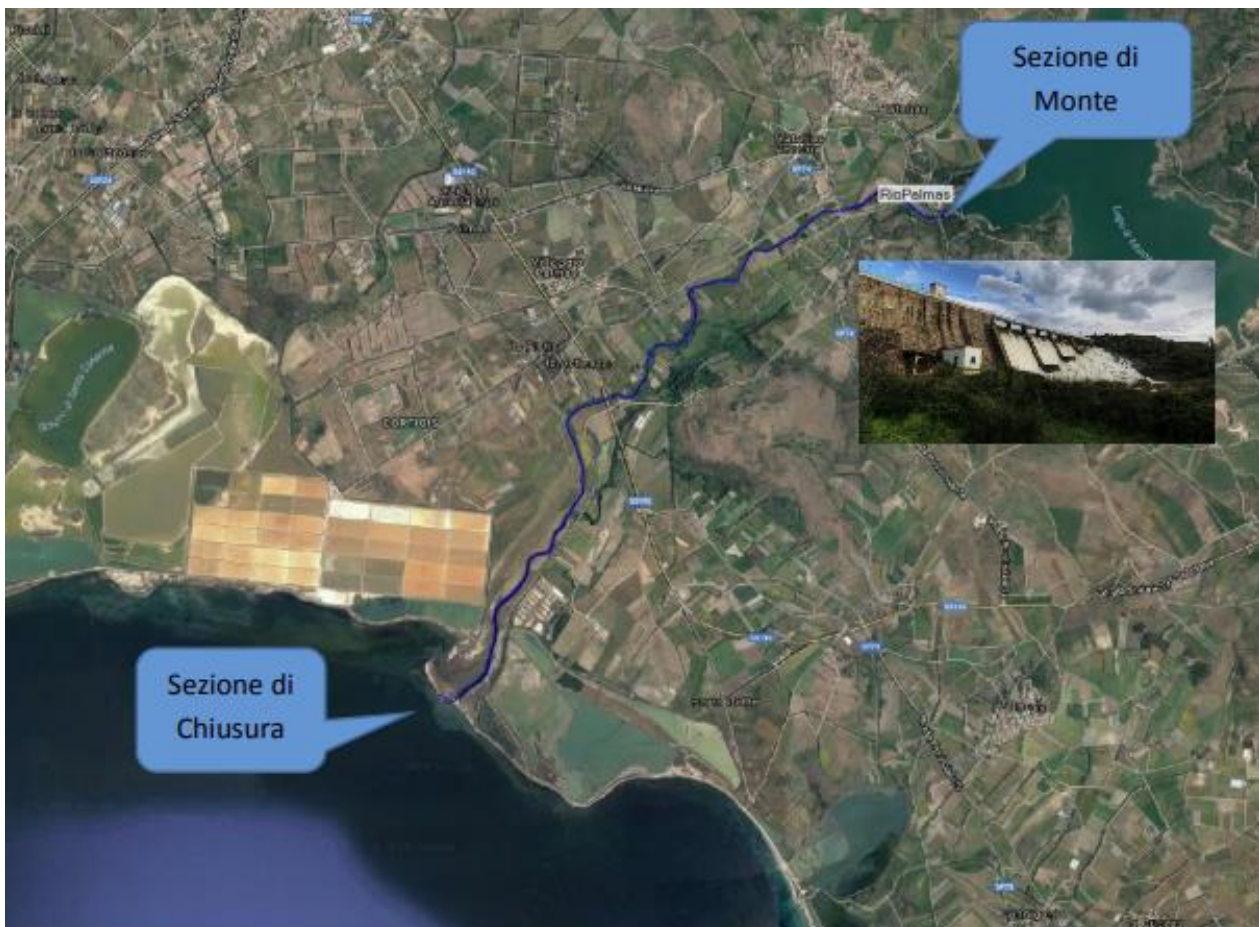
Figura 9-13: Sezione di monte e vale del tratto del Riu Palmas analizzato dal P.S.F.F.
