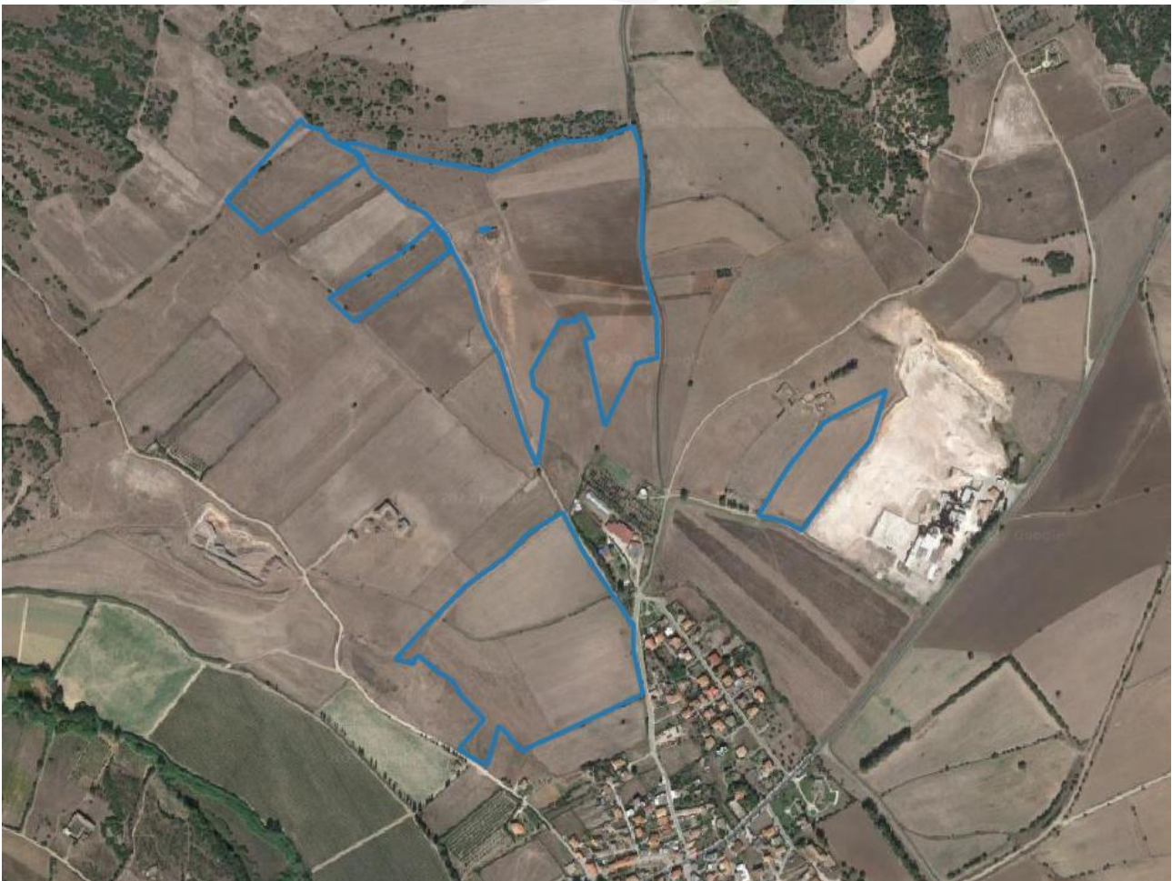
Fig. 1-3: Stato di fatto
