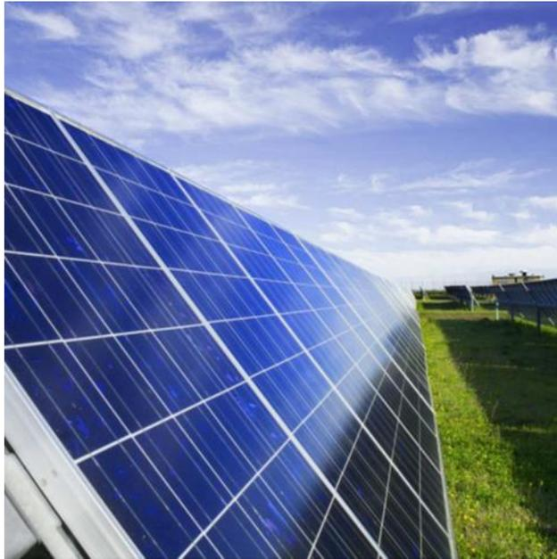
Il tracker monoassiale è di tipo orizzontale ad asse singolo ed utilizza dispositivi elettromeccanici per inseguire il sole durante tutto il giorno da est a ovest sull'asse di rotazione orizzontale nord-sud (inclinazione  $0^\circ$ ).
