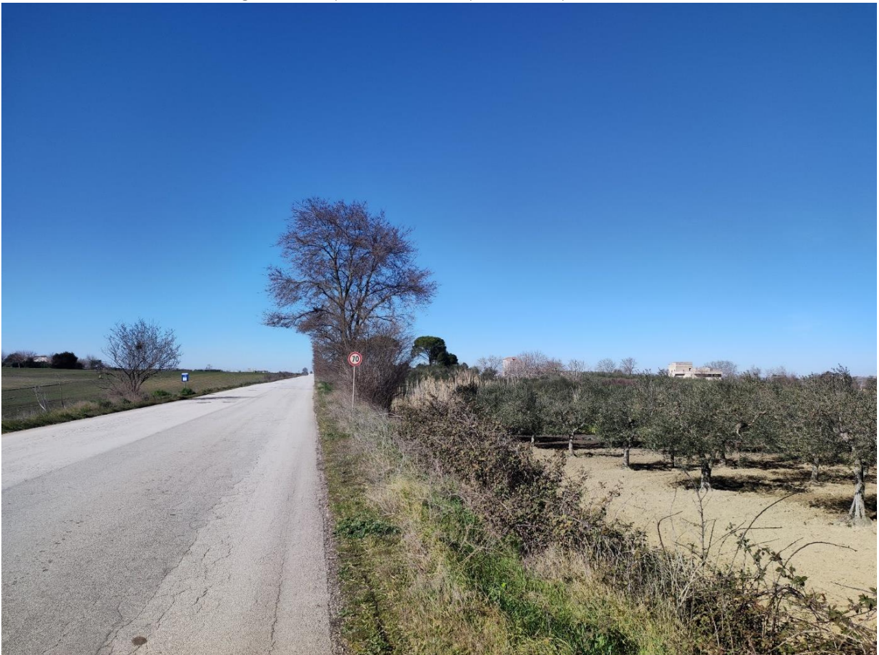
Fig. 64. Punto di presa 15. Stato di fatto.
