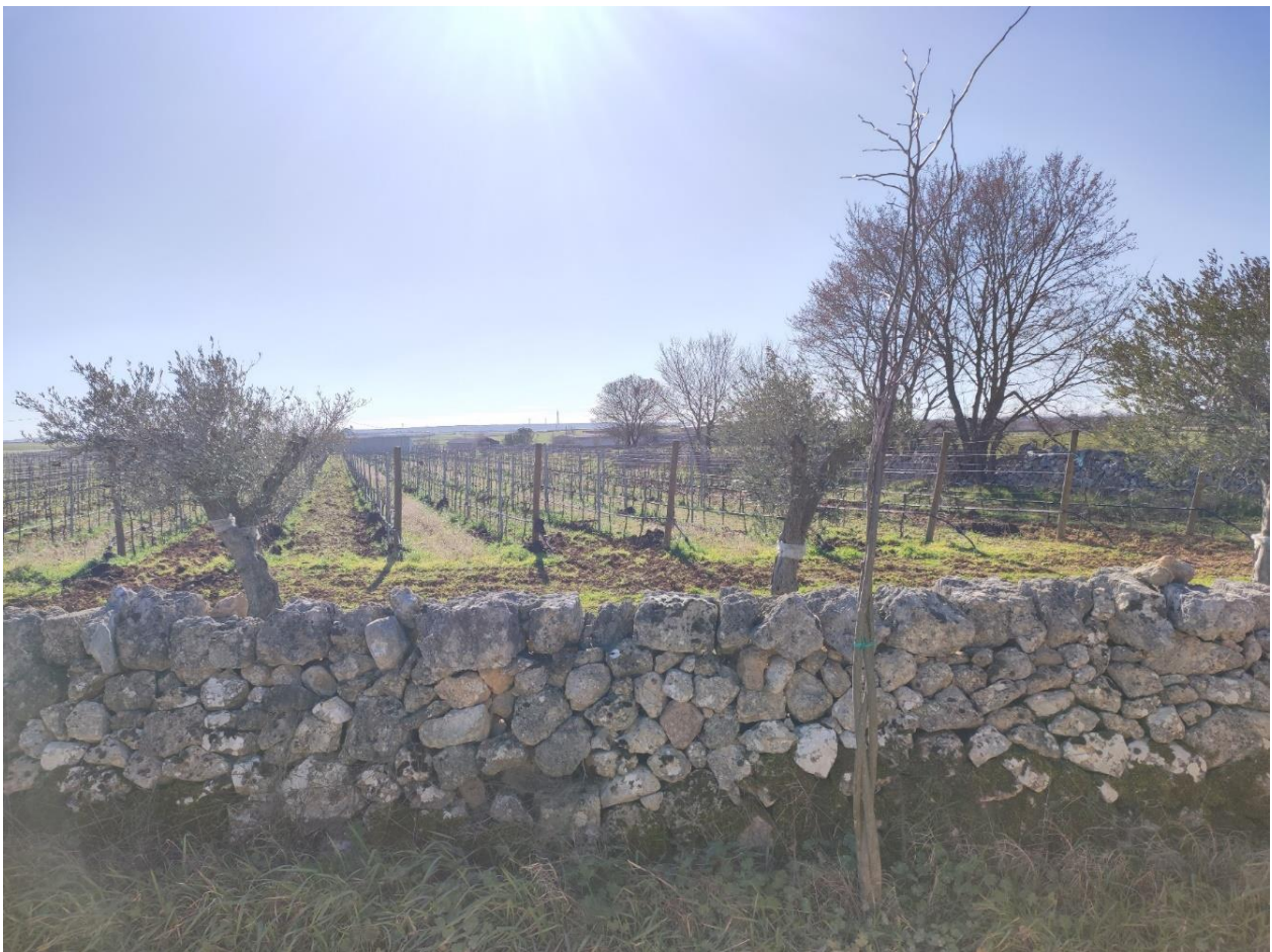
Fig. 12. Punto di presa 2. Stato di fatto.
