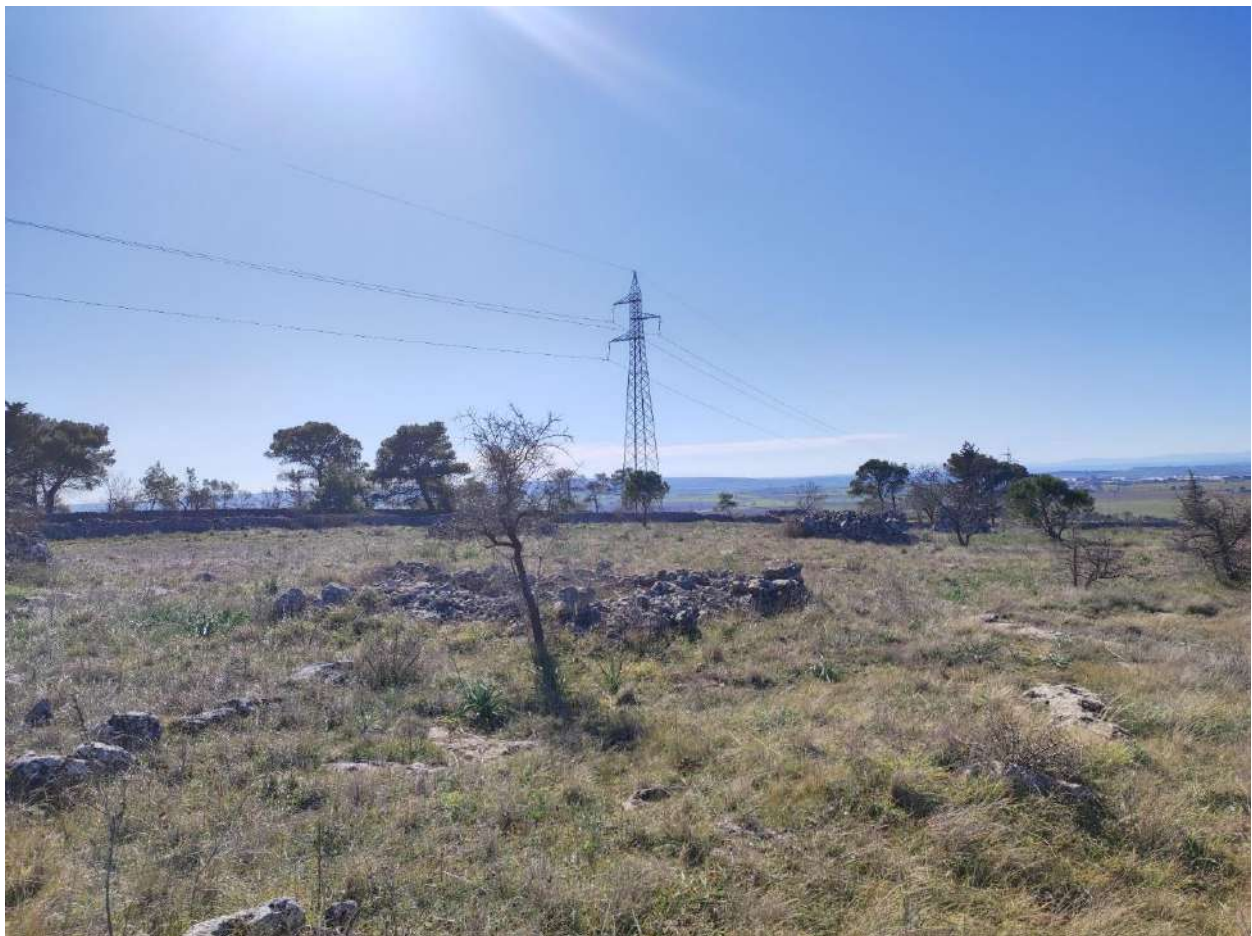
Fig. 93. Punto di presa 10. Stato di fatto.
