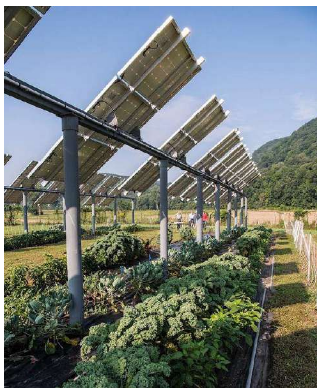
Figura 1– Esempio di integrazione tra attività agricola e produzione di energia da fonte fotovoltaica
