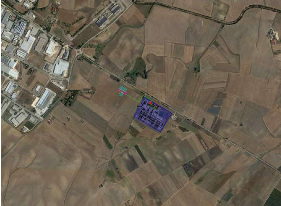
Figura 2.1 – Ortofoto della Stazione Elettrica di Trasformazione
