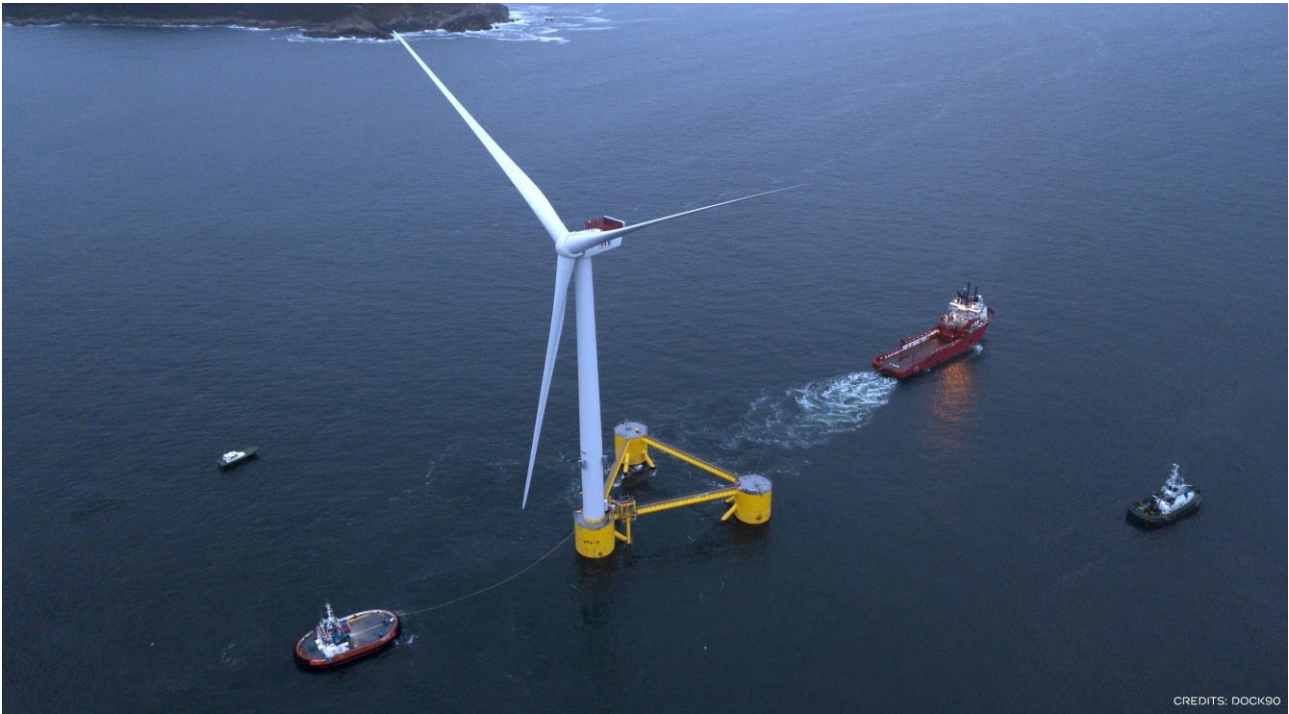
Figura 6-6 – Esempio dell’operazione di rimorchio (Fonte Windfloat Atlantic Project)
