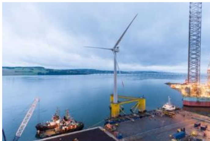
Figura 6-2 – Assemblaggio piattaforma galleggiante (Fonte kinkardine -Cobra)
