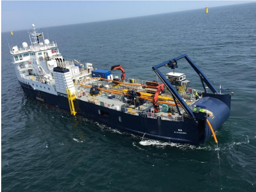
Figura 6-7 – Illustrazione dell'installazione del cavo (Fonte: Offshore Gode-wind)
