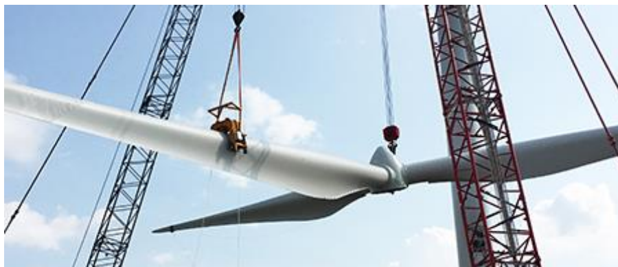
Figura 6-5 – Sollevamento del rotore (Fonte: Elronic Wind solution)
