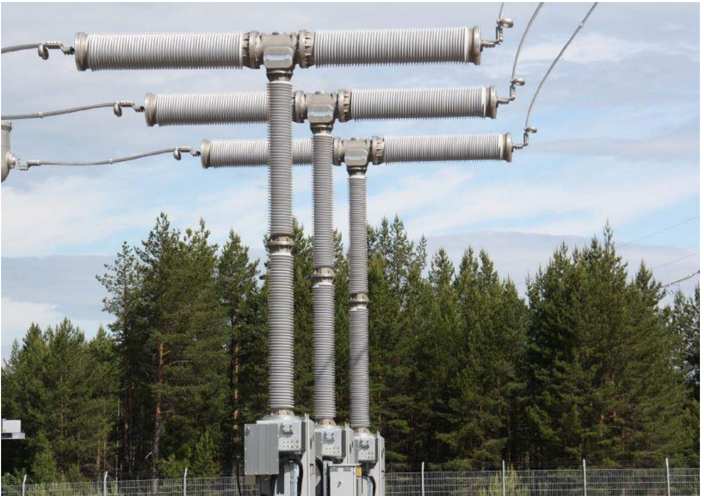
Figura 29 - interruttore 420kV (fonte Siemens)
