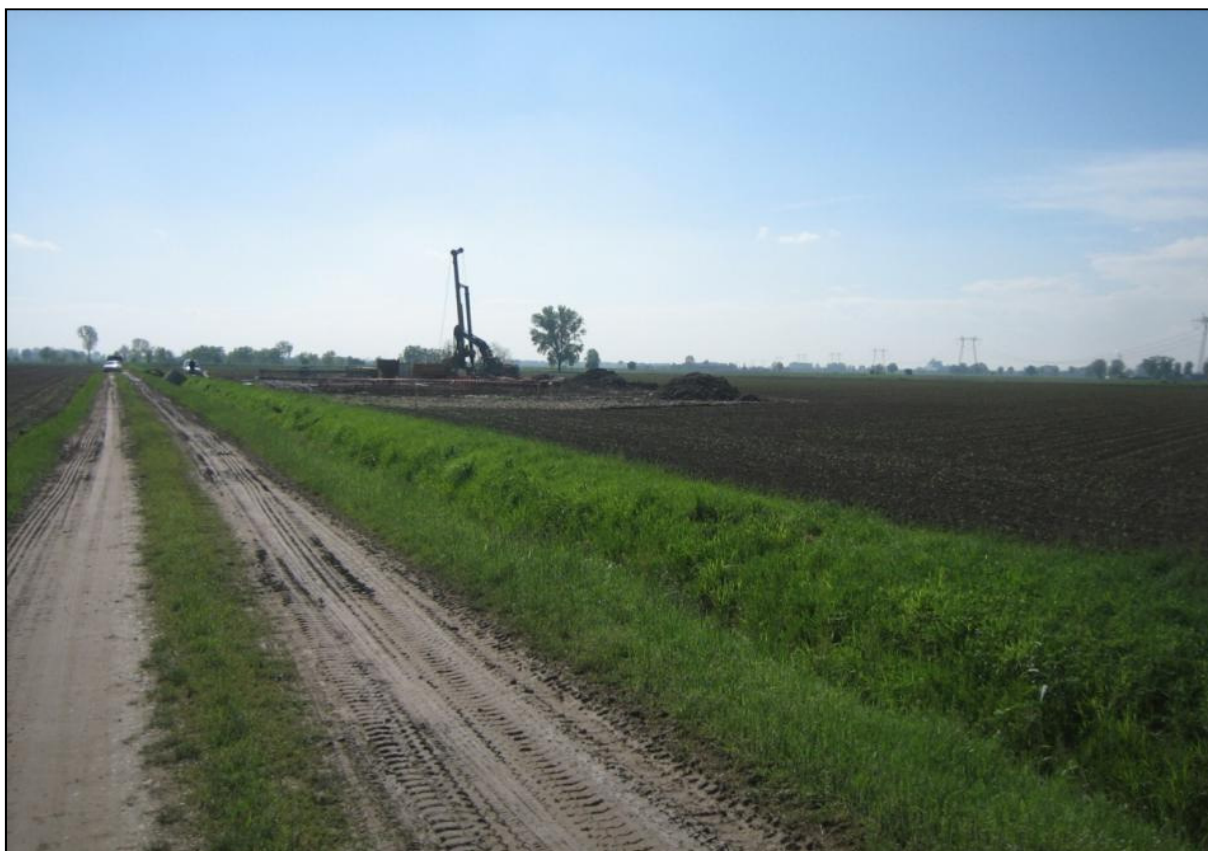
Figura 3-27 Esempio di micro cantiere con pista di accesso
