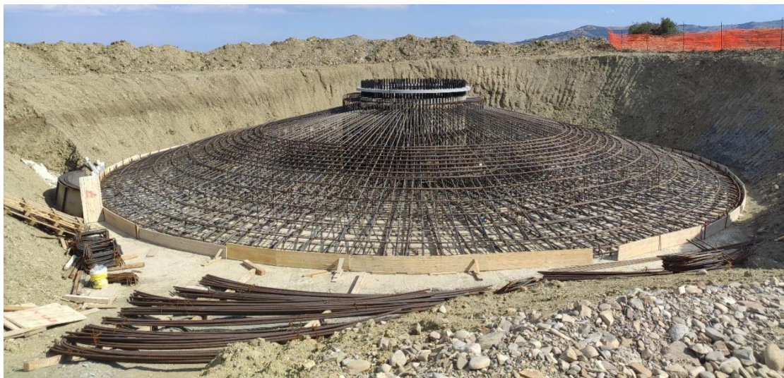
Figura 4: armatura plinto tipo
