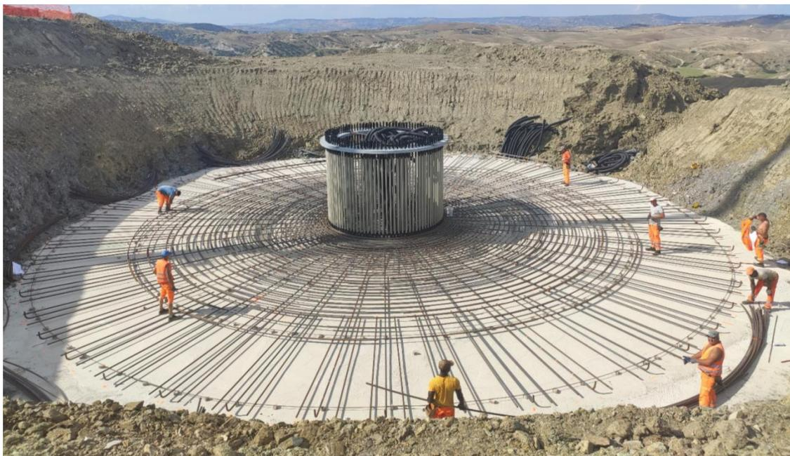
**Figura 5-3: immagine tipo posa anchor cages**
