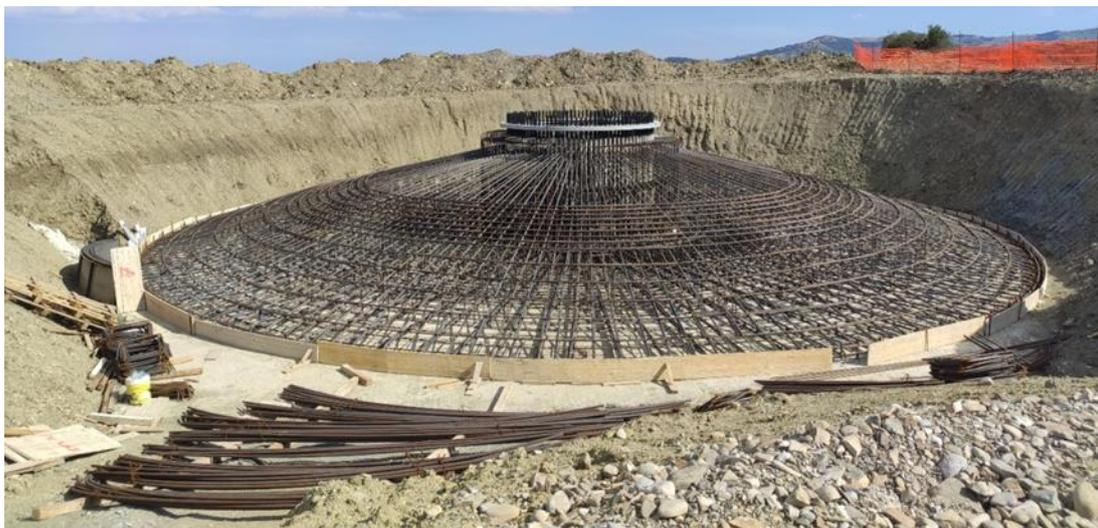
**Figura 5-4: immagine tipo armature plinto**
