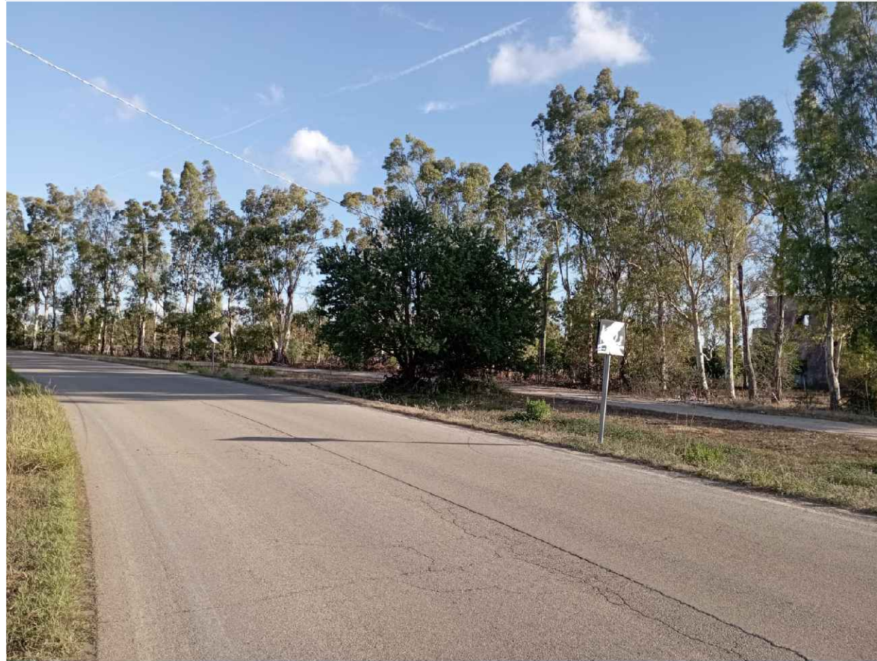
PUNTI DI VISTA n.5 - SP81 nei pressi della Masseria Torricella, Comune di Brindisi - ante operam
