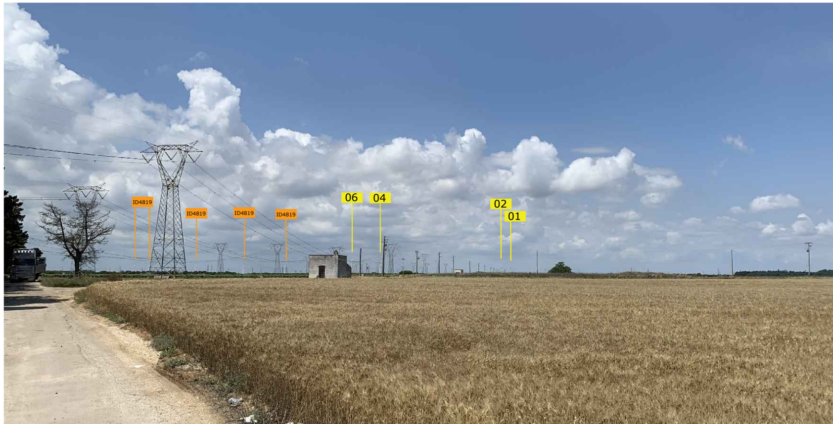
PUNTI DI VISTA n.11 - SS16 Strada a Valenza Paesaggistica - post operam
