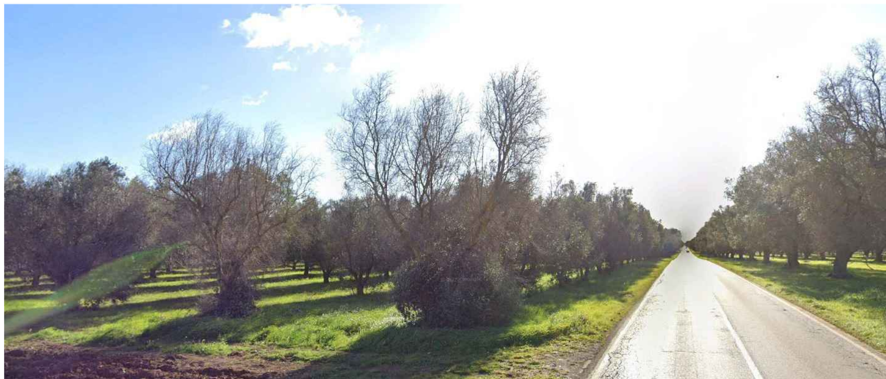
PUNTI DI VISTA n.12 - SS605 Strada a Valenza Paesaggistica nei pressi della Masseria Canali, Comune di Mesagne - ante operam
