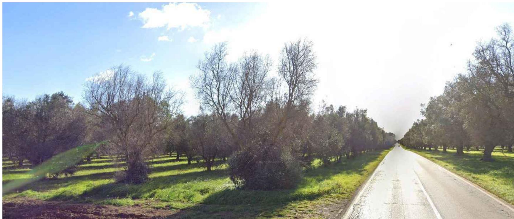
PUNTI DI VISTA n.12 - SS605 Strada a Valenza Paesaggistica nei pressi della Masseria Canali, Comune di Mesagne - post operam
