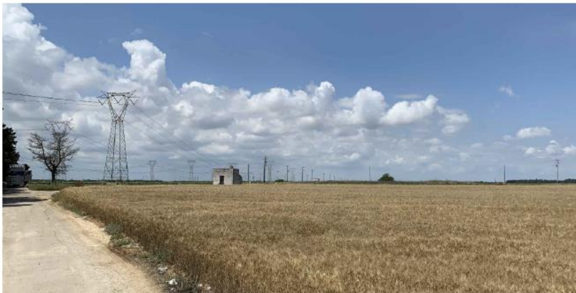
PUNTI DI VISTA n.11 - SS16 Strada a Valenza Paesaggistica - ante operam
