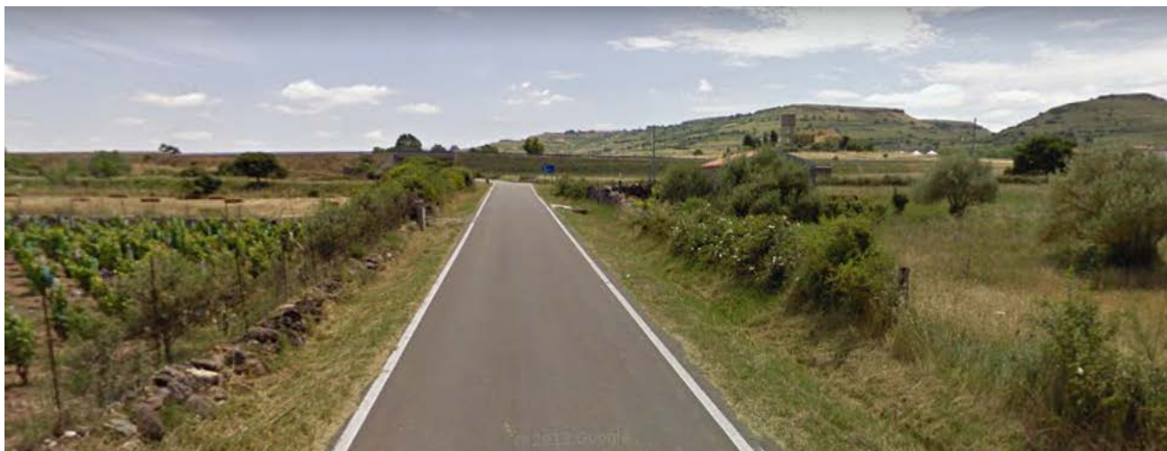
Foto 13: sopralluogo UR 6 - settembre 2021.
