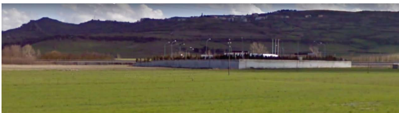
Foto 20: sopralluogo UR 9 - aprile 2022.
