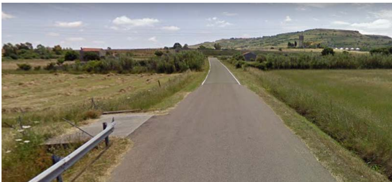
Foto 12: sopralluogo UR 5 - settembre 2021.
