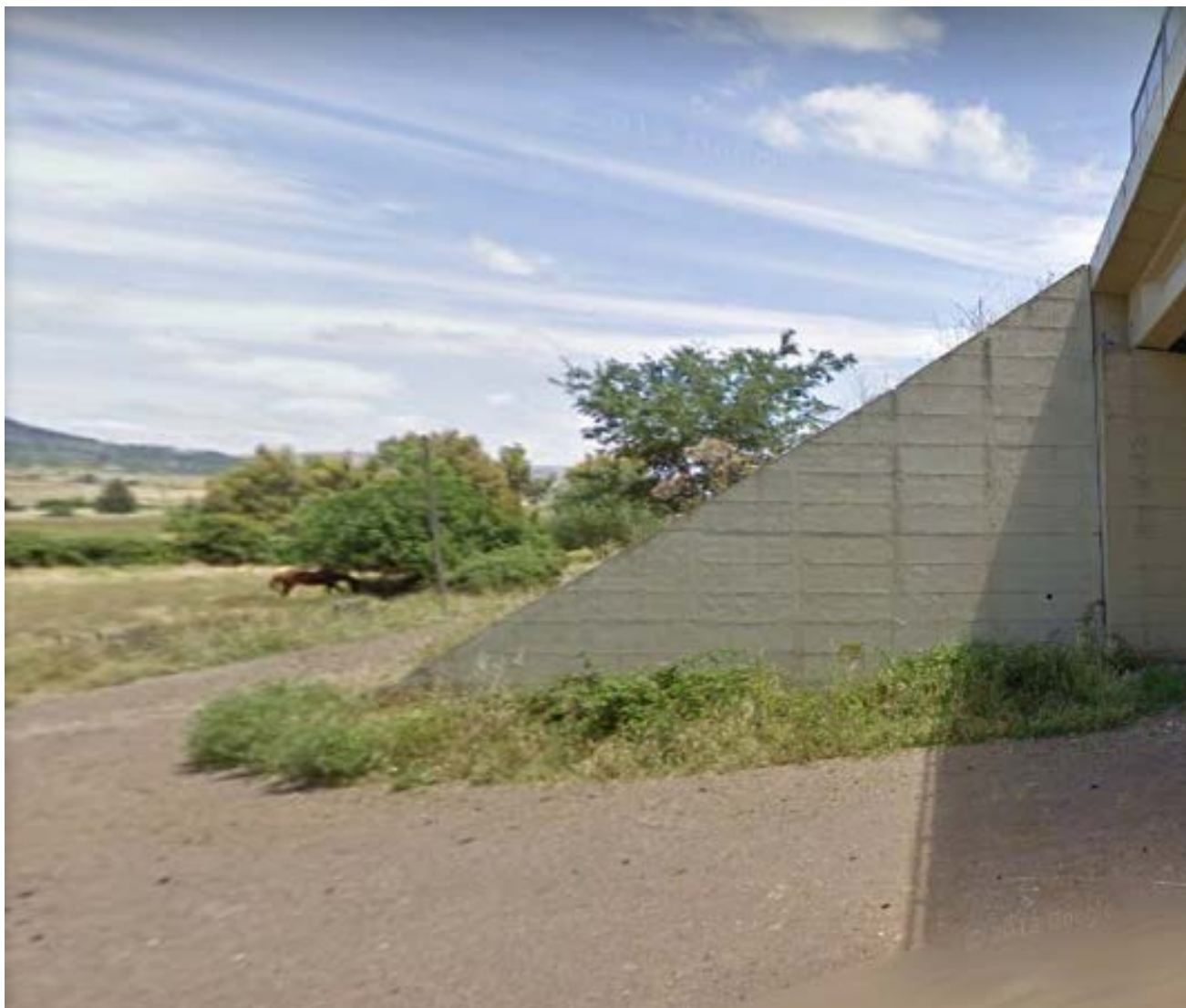
Foto 16: sopralluogo UR 7 - aprile 2022.
