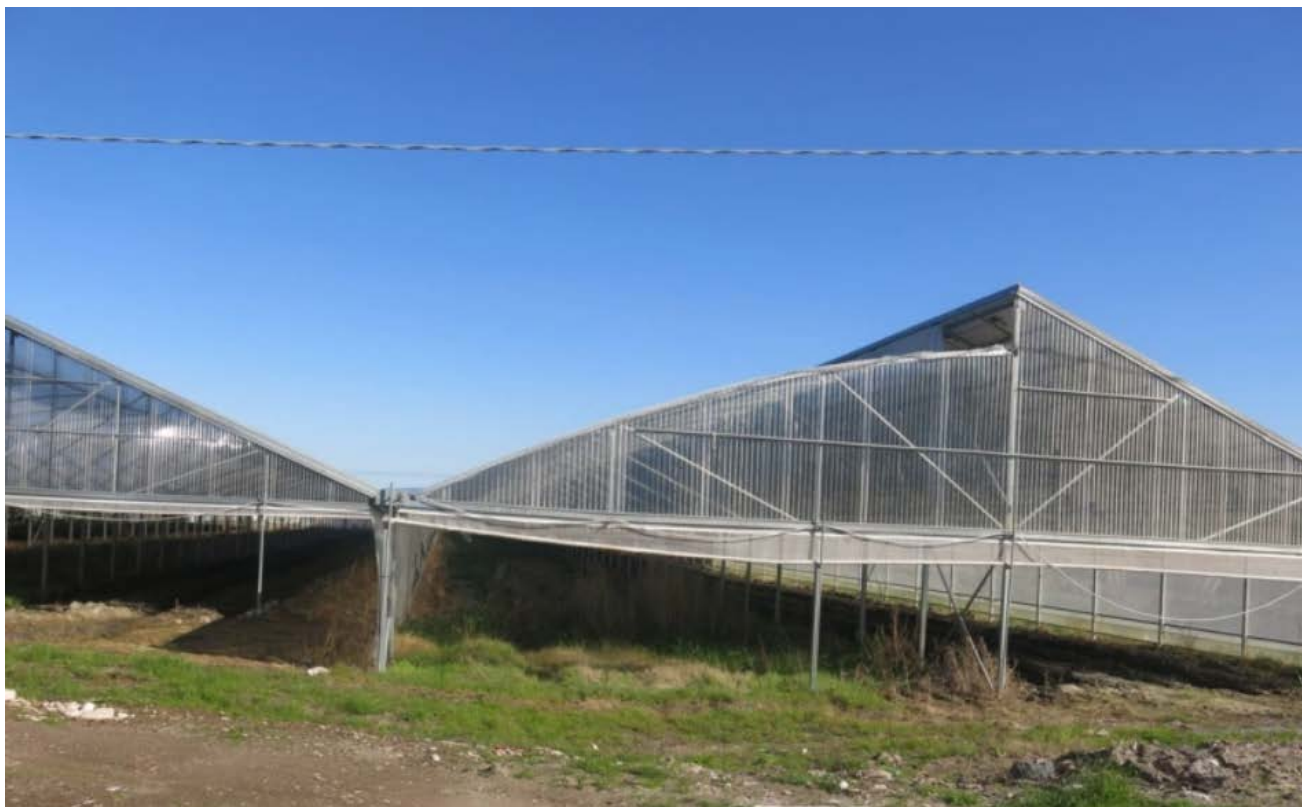
Foto 3: sopralluogo UR 1 - aprile 2022.
