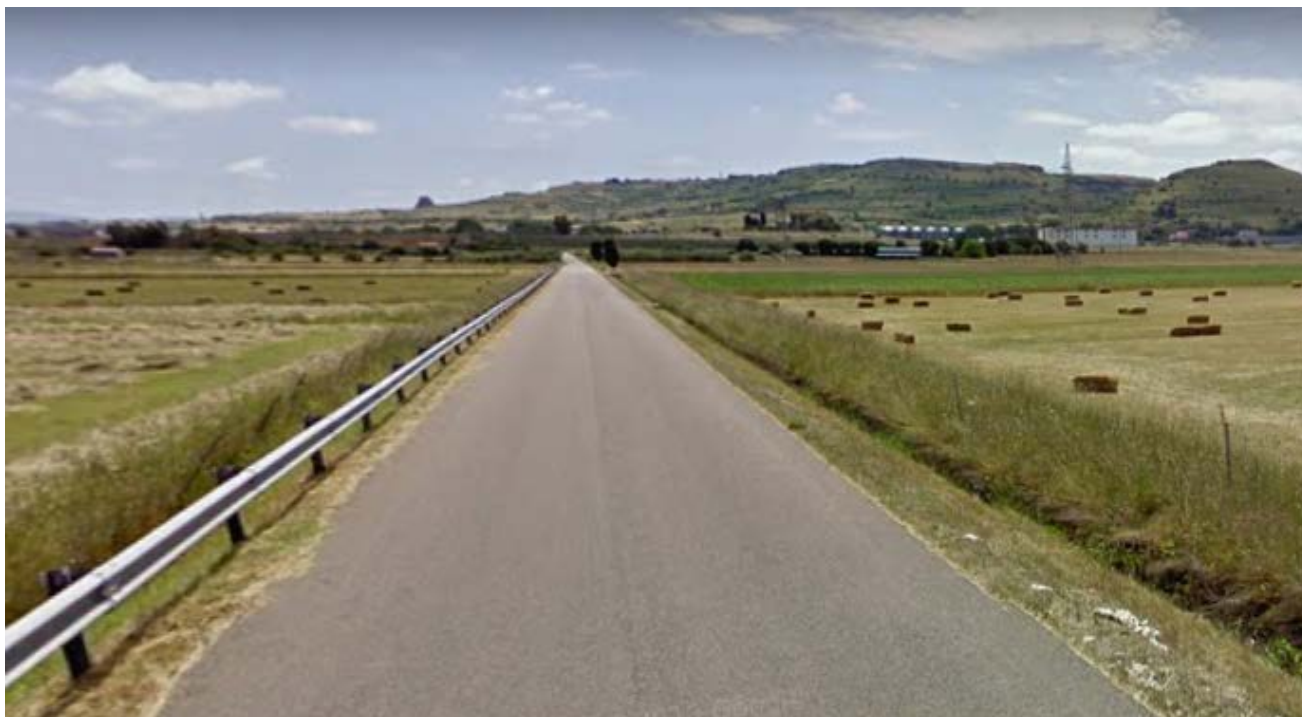
Foto 11: sopralluogo UR 5 - settembre 2021.
