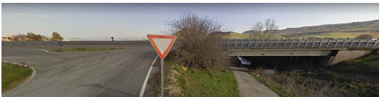
Foto 22: sopralluogo UR 10 - aprile 2022.
