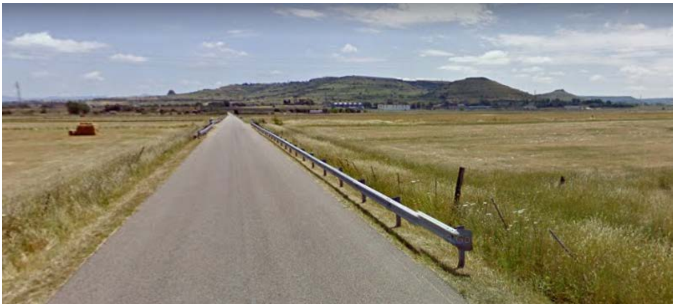
Foto 10: sopralluogo UR 4 - settembre 2021.
