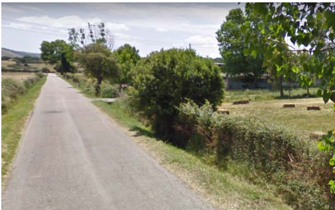
Foto 6: sopralluogo UR 2 - settembre 2021.
