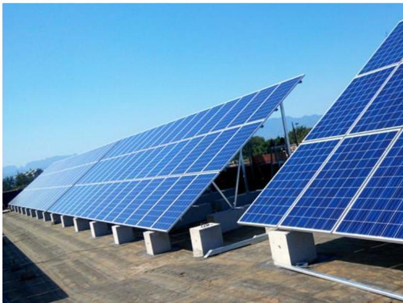
Figura 6: Esempio di impianto fotovoltaico con fondazioni formate da zavorre costituite da plinti in cemento.
