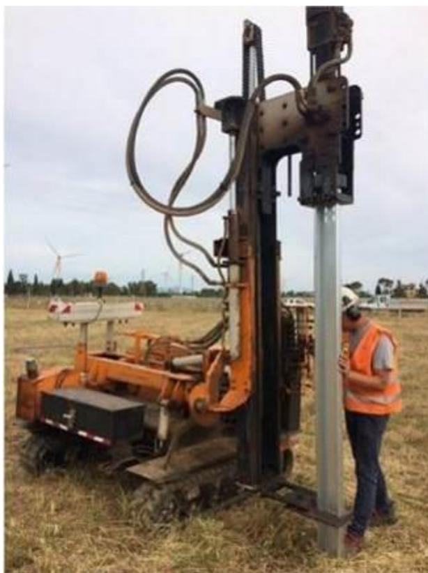
**Figura 1: Esempio di supporto costituito da palo in acciaio infisso direttamente nel terreno mediante battipalo.**
