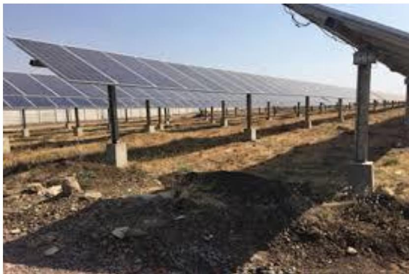
Figura 4: Esempio di impianto fotovoltaico con fondazioni ottenute mediante perforazione del terreno e successiva creazione del palo di fondazione con getto di cemento.
