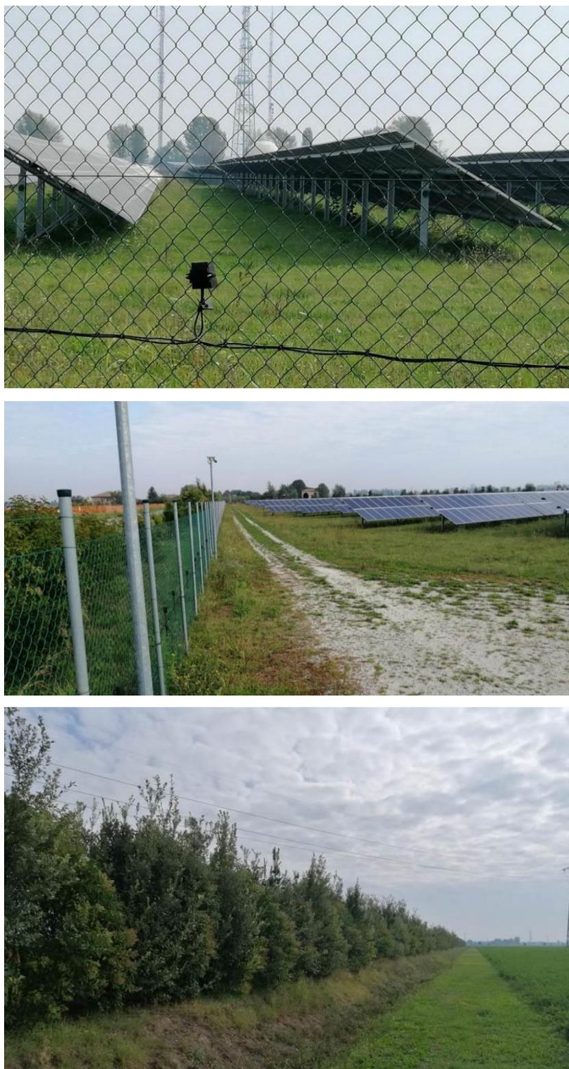
**Figura 14: Esempio di realizzazione di un impianto fotovoltaico senza fondazioni in cls e senza impermeabilizzazione del suolo, con schermatura perimetrale mediante siepi arbustive (scelte progettuali analoghe a quelle adottate per l'impianto in esame).**
