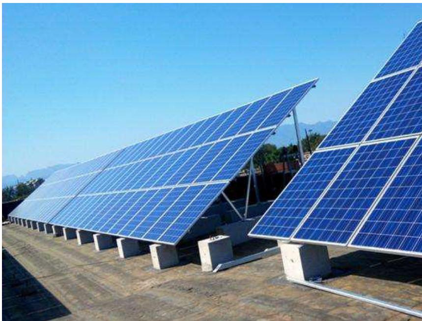
Figura 32: Esempio di impianto fotovoltaico con fondazioni formate da zavorre costituite da plinti in cemento.
