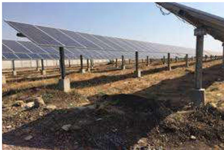
Figura 30: Esempio di impianto fotovoltaico con fondazioni ottenute mediante perforazione del terreno e successiva creazione del palo di fondazione con getto di cemento.
