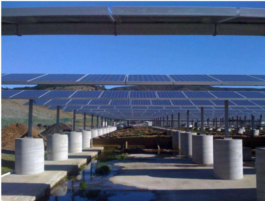
Figura 31: Esempio di impianto fotovoltaico con fondazioni ottenute mediante perforazione del terreno e successiva creazione del palo di fondazione con getto di cemento.
