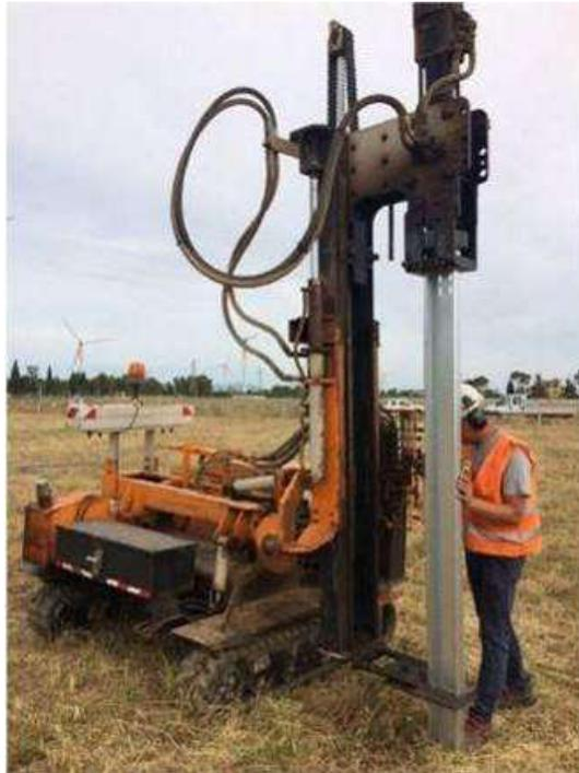
**Figura 27: Esempio di supporto costituito da palo in acciaio infisso direttamente nel terreno mediante battipalo.**
