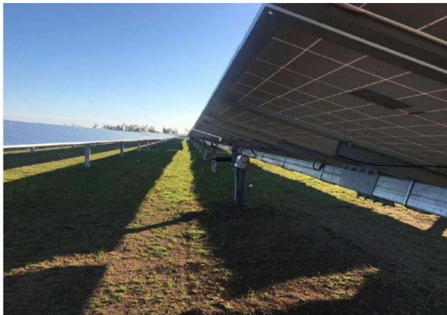
**Figura 28: Esempio di impianto fotovoltaico realizzato con supporti costituiti da pali in acciaio infissi direttamente nel terreno. Gli impatti sul suolo sottostante risultano essere minimizzati.**
