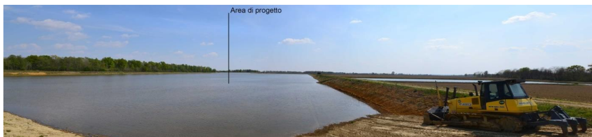
Foto 02 – Panoramica in direzione sud-ovest dell'area di progetto.
