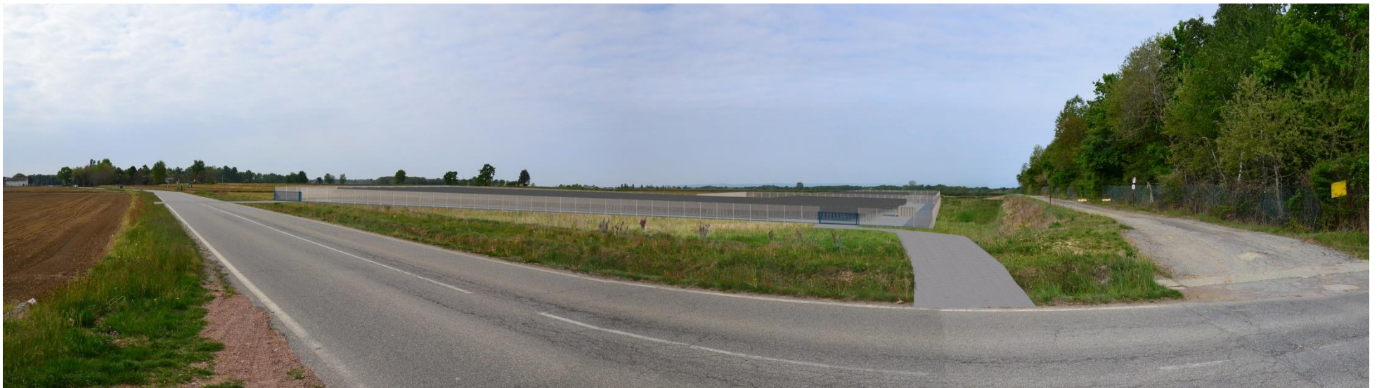
Figura 8.7 - Stato di progetto senza gli interventi di mitigazione e compensazione per l'inserimento paesaggistico-ambientale. L'immagine mostra l'area di intervento al termine dell'installazione degli elementi tecnologici per la produzione di energia elettrica rinnovabile.
