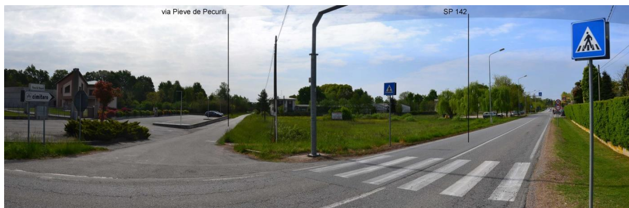
Foto 19 – Panoramica in direzione sud-ovest, verso l'area di progetto della cabina di connessione, dalla SP 142. L'area di progetto, posta ad oltre 1700 metri di distanza, non risulta visibile.
