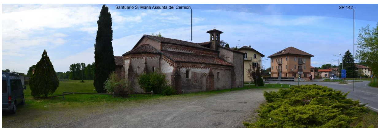
Foto 18 – Panoramica verso le aree di progetto dalle aree di pertinenza del Santuario di S. Maria Assunta dei Cerniori in Curavecchia. Le aree di progetto non risultano visibili.
