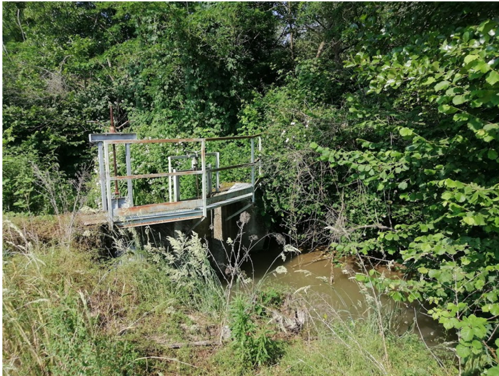
FOTO. 1 – Particolare della paratia che governa il cavo irriguo al margine Nord
