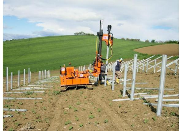
Figura 4 - Posa strutture metalliche di fondazione
