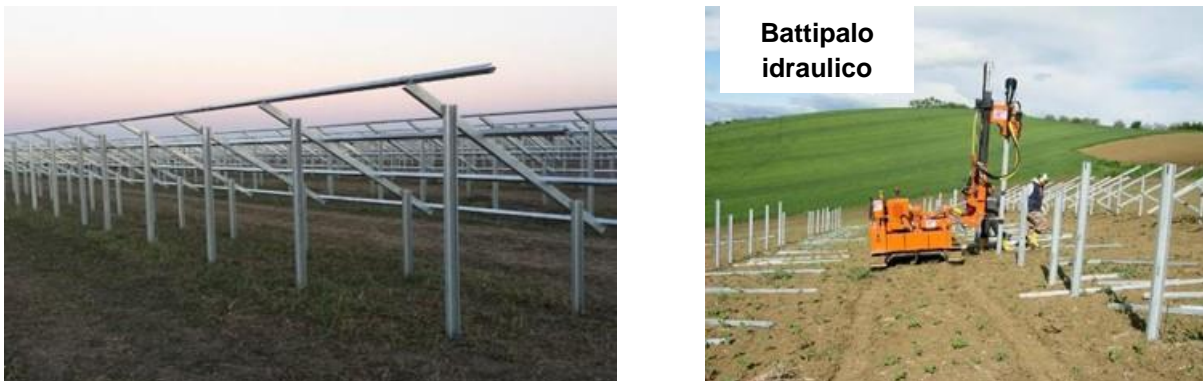
Figura 5-2 – Esempio di posa delle strutture portanti.
