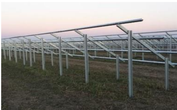
Figura 6-1 – Esempio di posa delle strutture portanti.
