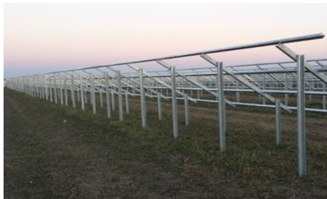
Figura 3-11 - Stato cantiere al termine della fase lavorativa
