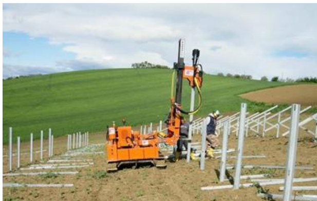
Figura 3-10 – Messa in opera delle strutture di sostegno
