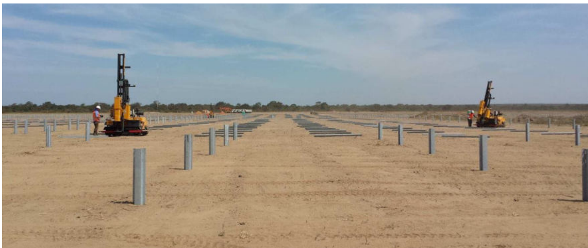
Figura 4 – Esempio di infissione dei pali con profilo omega
