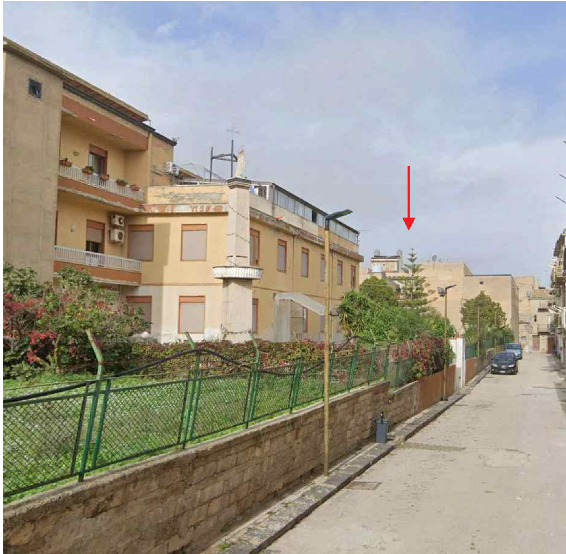
FOTO P3A - CENTRO URBANO CAMASTRA - (ANTE OPERAM)
