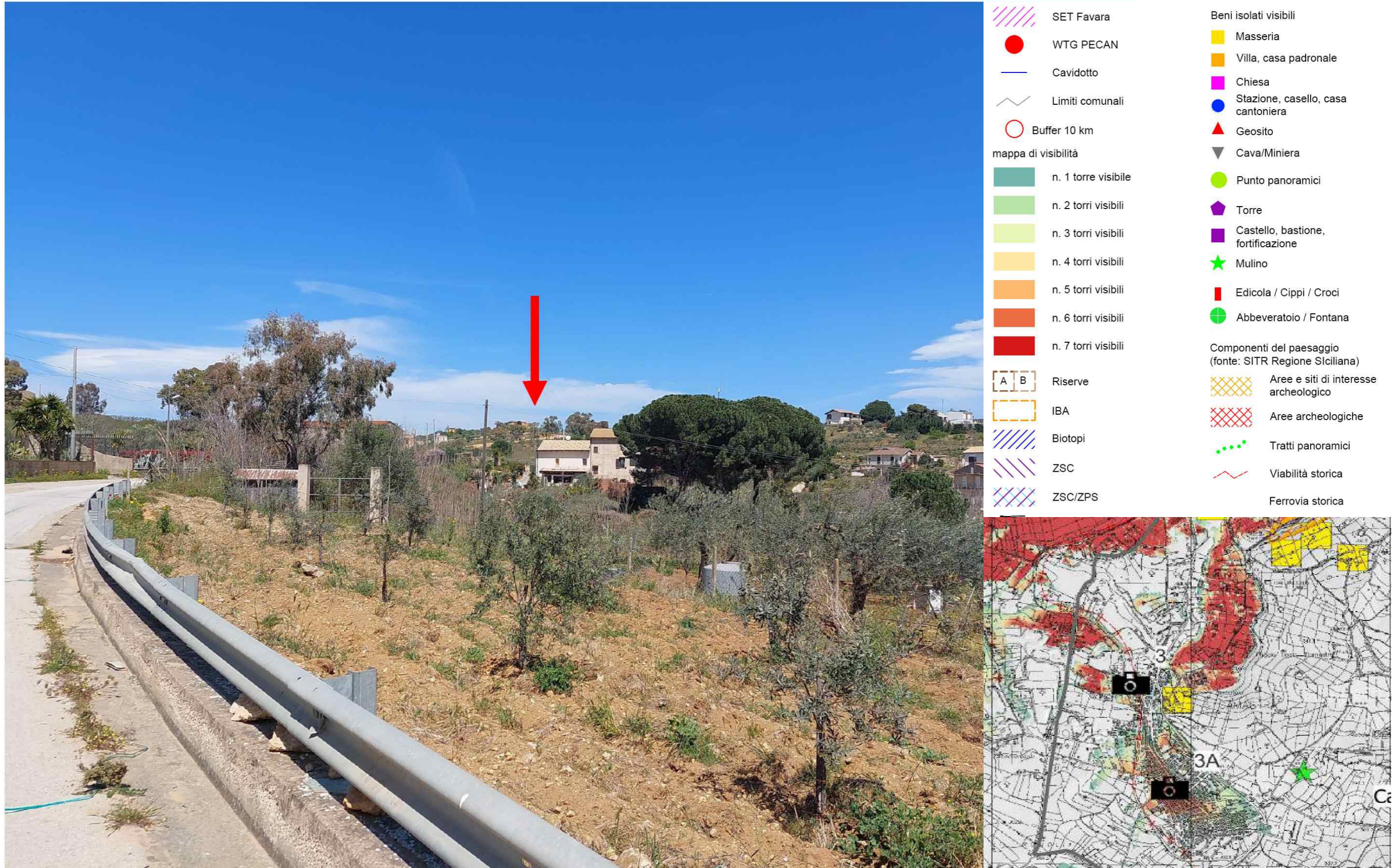
FOTO 3 – CENTRO URBANO - CAMASTRA - (ANTE OPERAM)
