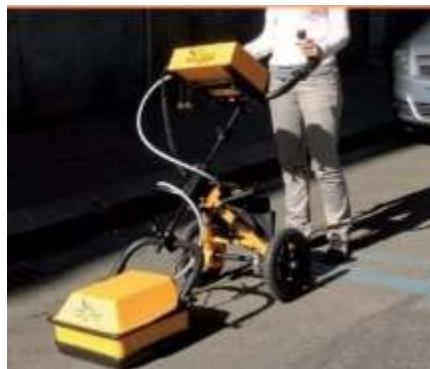
Fig.14-Verifica presenza sottoservizi con georadar
