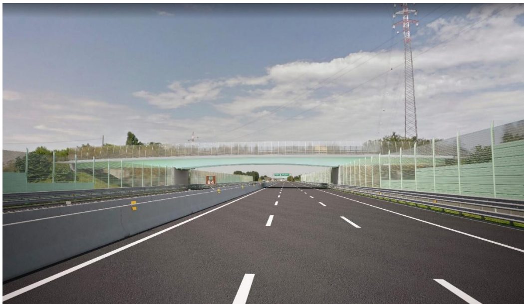
Figura 36: cavalcavia NCS S 1510-B80G con FOA RAL6019 - prove colori Progetto Esecutivo. In carreggiata nord barriere acustiche h 5 m, in carreggiata sud barriere acustiche h 3 m. Per rendere simmetrico il trattamento delle due barriere e la percezione del cavalcavia si prevedono 11 campate trasparenti per entrambe i lati
