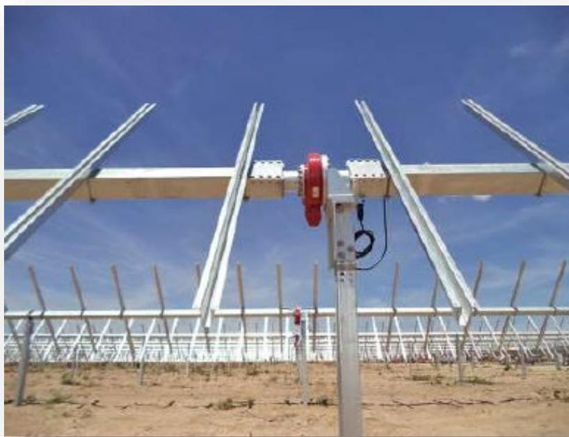
**Figura 9- Struttura dell'inseguitore solare monoassiale**
