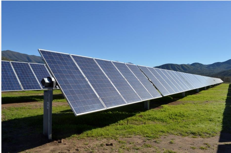
Figura 7 - Vista prospettica inseguitore solare monoassiale
