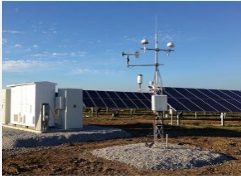
**Figura 17- Stazione meteorologica tipo**
