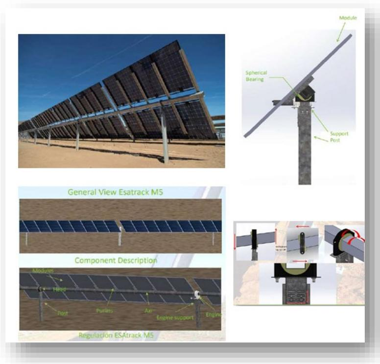
**Figura 6 - Strutture di sostegno e sistema di inseguimento solare**
