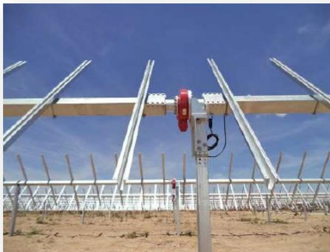
Figura 25- Struttura dell'inseguitore solare monoassiale
