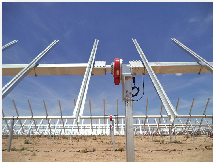
Figura 2 – Struttura dell'inseguitore solare monoassiale
