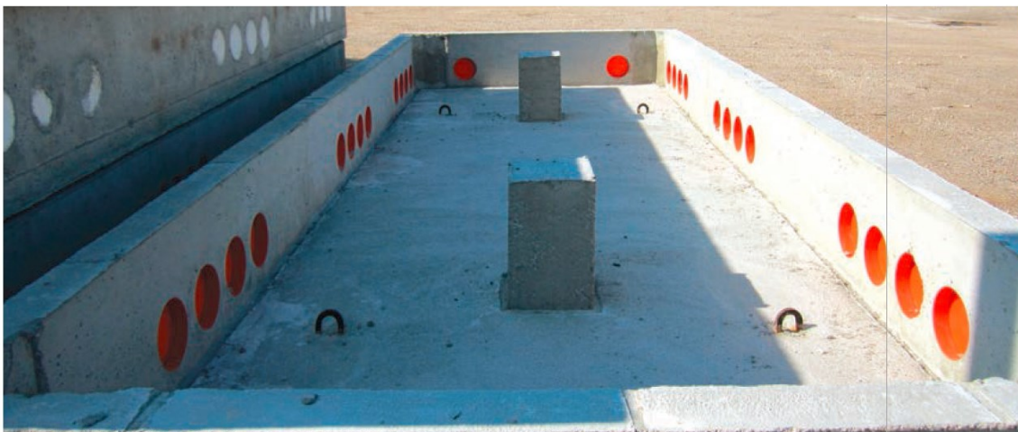
Figura 3 - Vasca di fondazione in CAV
