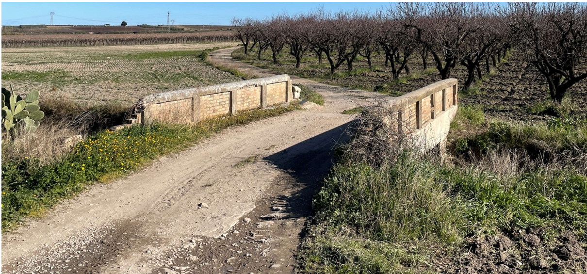
Figura 5. Vista dell'attraversamento in corrispondenza dell'intersezione INT3
