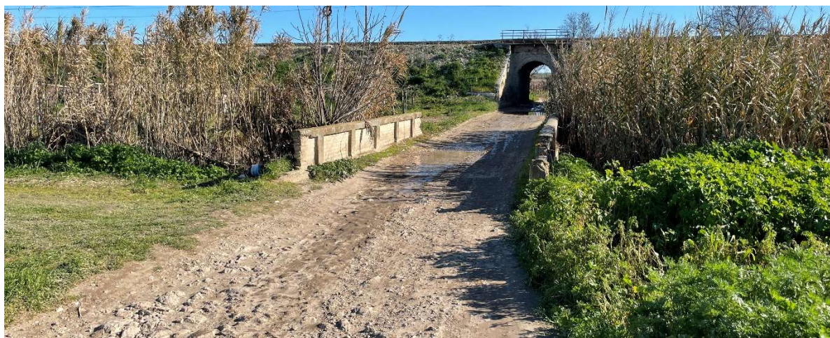
Figura 3. Vista dell’attraversamento in corrispondenza dell’intersezione INT2
