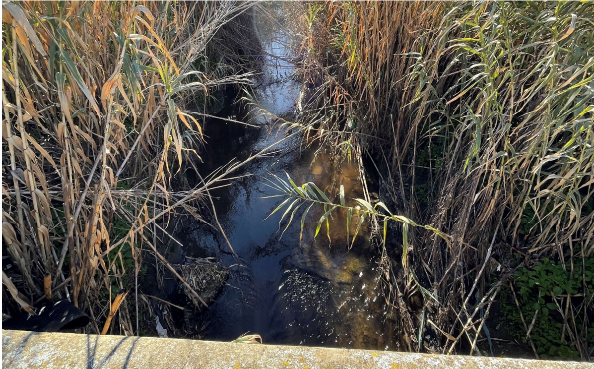
Figura 4. Corso d'acqua in corrispondenza dell'intersezione INT2
