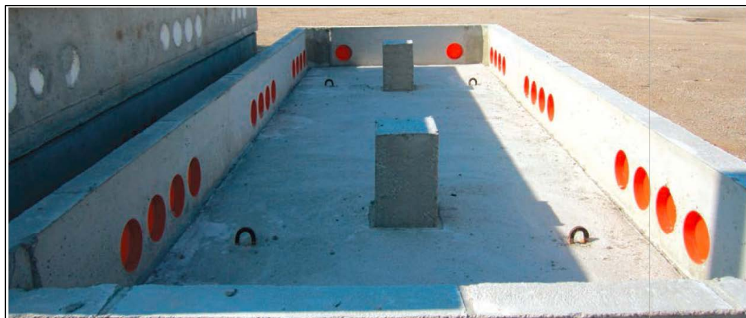
Figura 12 Vasca di fondazione in CAV
