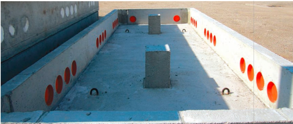
Figura 2 Vasca di fondazione in CAV
