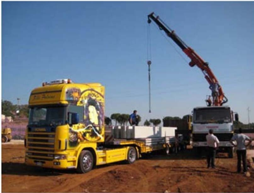
Figura 13 | Attività di scarico cabina di campo
